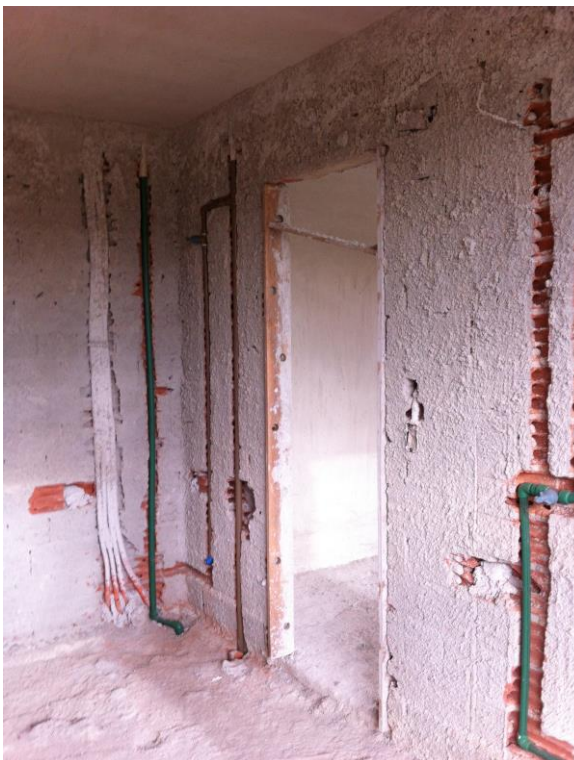
Figura 5 – Fotografia da execução de alterações nas instalações hidráulicas. Fonte: Autoria própria.
