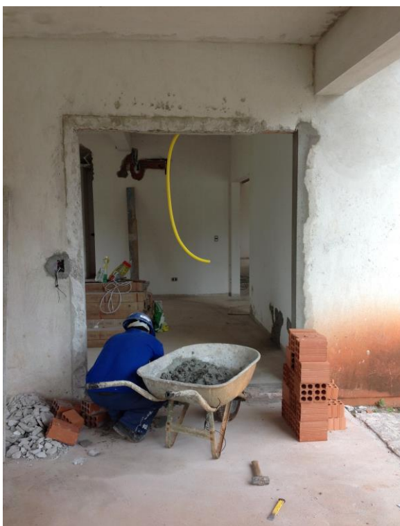
Figura 4 – Fotografia da execução de alterações em alvenaria. Fonte: Autoria própria.
