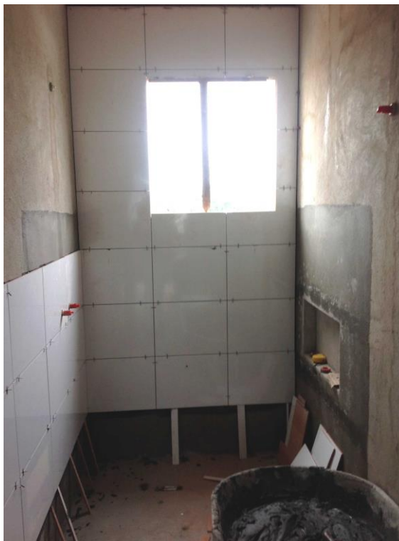
Figura 6 – Fotografia da colocação de azulejos. Fonte: Autoria própria.
