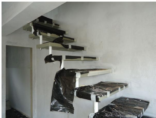
**Figura 9 – Escada pré-fabricada engastada na parede**
