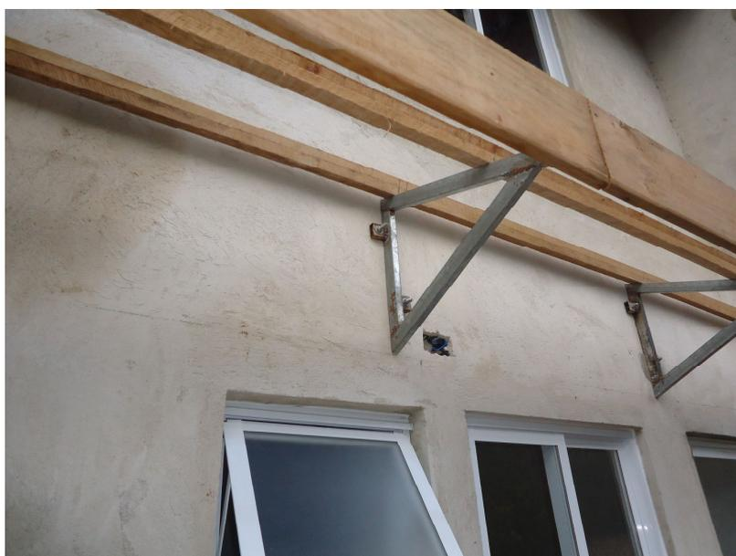
**Figura 10 – Mão-francesa metálica, eliminando etapa de corte e ligação da madeira**
