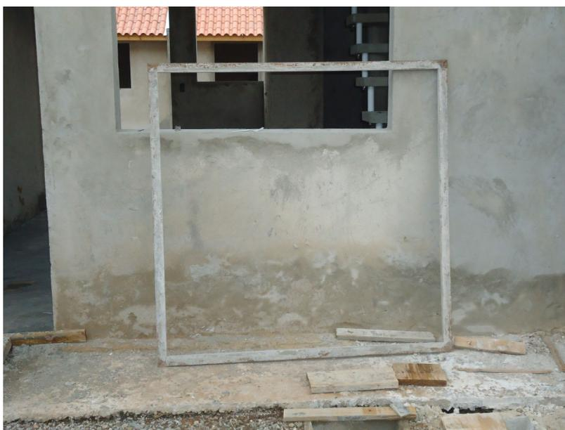
**Figura 7 – Gabarito metálico utilizado para reduzir a variabilidade no resultado**
