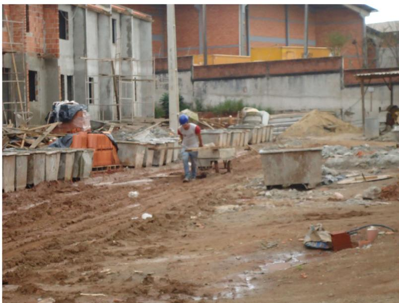
**Figura 8 – Transporte de material por acesso inadequado**
