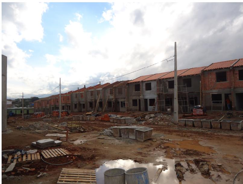
**Figura 6 – Vista parcial do canteiro de obras com as edificações em diferentes etapas de execução**
