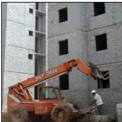
Figura 7 - Manipulador telescópico utilizado na construção civil. Fonte: FERREIRA, 2012.
