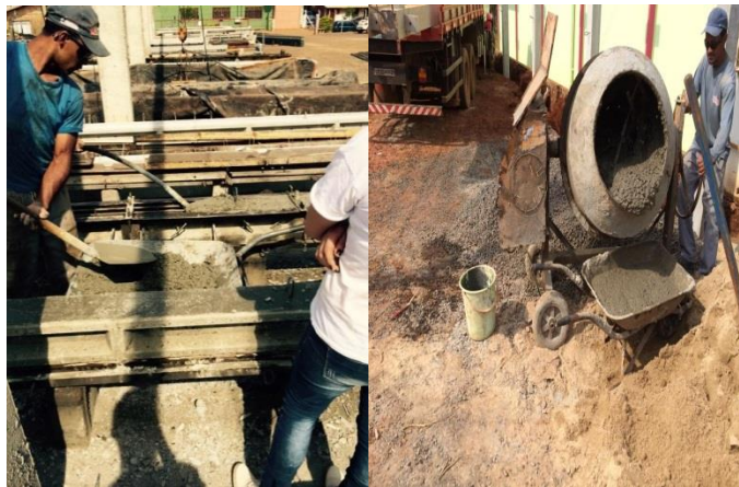
Figura 3: Empregados desempenhando a função de preenchimento das formas com concreto Fonte: O autor
