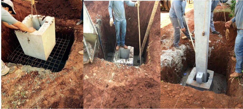
Figura 4: Locação e concretagem do gabarito Fonte: O autor
