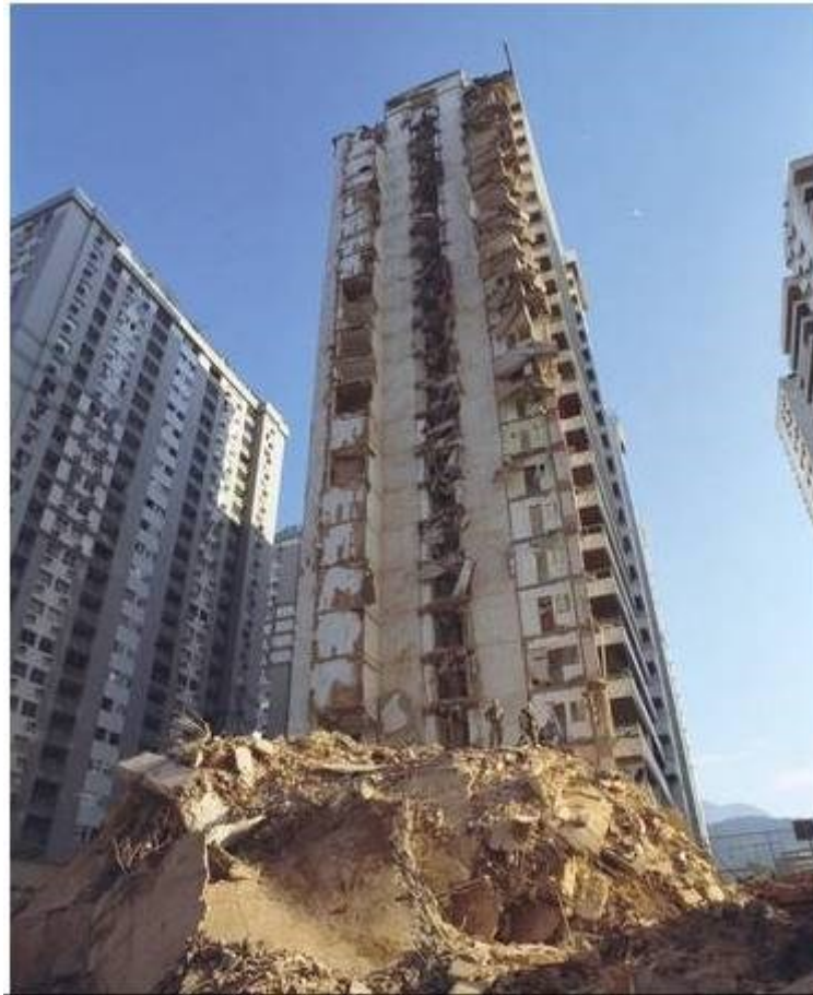
Figura 13 - Desabamento Palace II Fonte: O Globo (2013).
