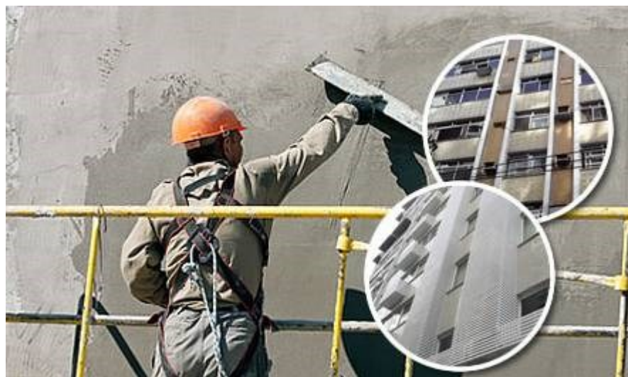
Figura 6: Modernização de Fachada Fonte: Prumo Manutenção (2017).
