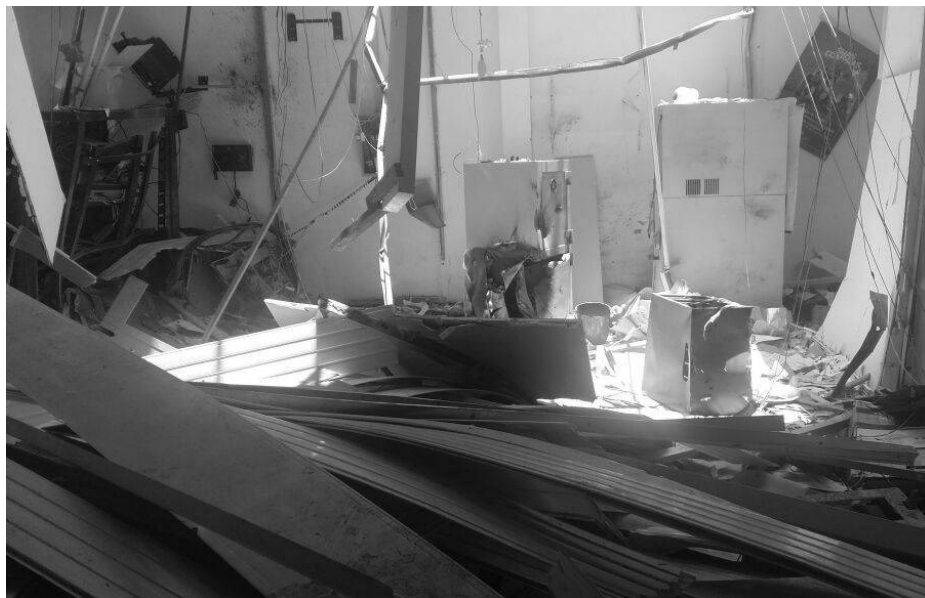
Figura 18 - Banco "X" após vandalismo Fonte: a autora (2017).
