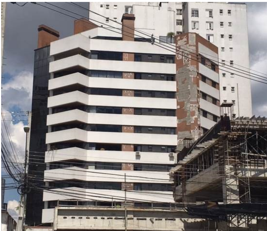
Figura 5 - Manutenção Restauração em fachada Fonte: a autora (2017).
