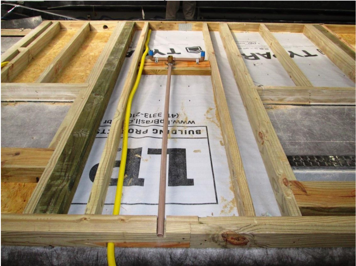
FIGURA 4 – EXEMPLO DE INSTALAÇÕES ELÉTRICAS E HIDROSSANITÁRIAS
