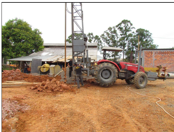
Figura 11 - Trator adaptado para perfuração de estacas escavadas
