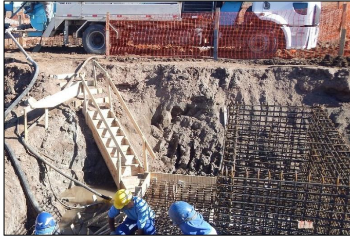
Figura 24 – Escavações com acesso para os trabalhos Fonte: Aatoria própria (2014)
