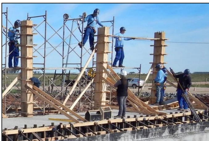
Figura 28 – Montagem simultânea de caixarias e andaime Fonte: Autoria própria (2014)
