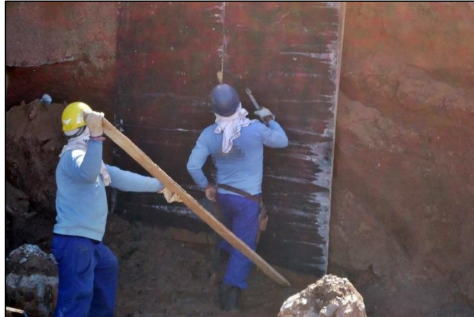
Figura 22 – Contenções para a terra nas escavações Fonte: Aatoria própria (2014)
