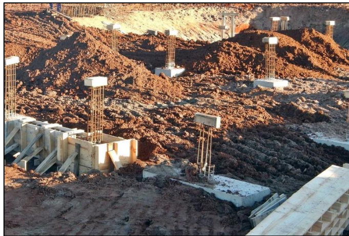
Figura 41 – Correta proteção para os vergalhões Fonte: Autoria própria (2014)
