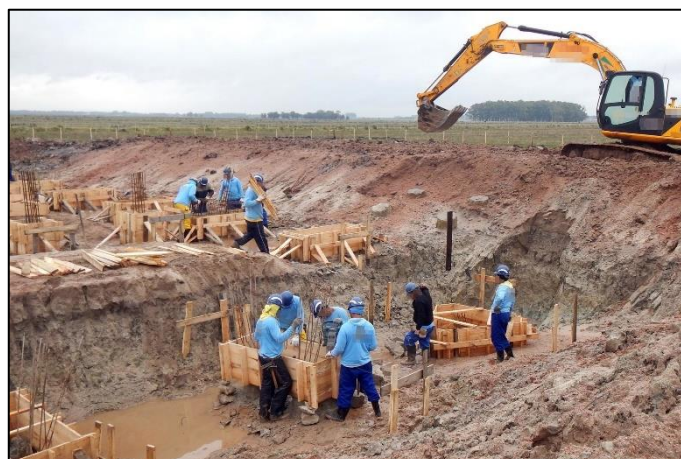
Figura 21 – Trabalhos simultâneos nas escavações Fonte: Aatoria própria (2014)
