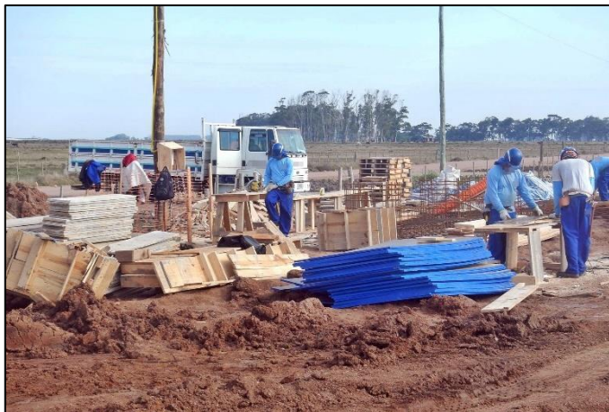
Figura 13 – Carpintaria improvisada na obra Fonte: Autoria própria (2014)
