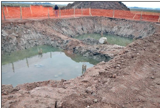
Figura 18 – Escavações em forma de talude Fonte: Aatoria própria (2014)
