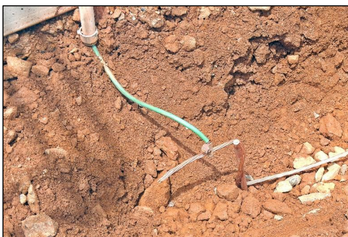
Figura 09 – Aterramento dos containers Fonte: Autoria própria (2014)
