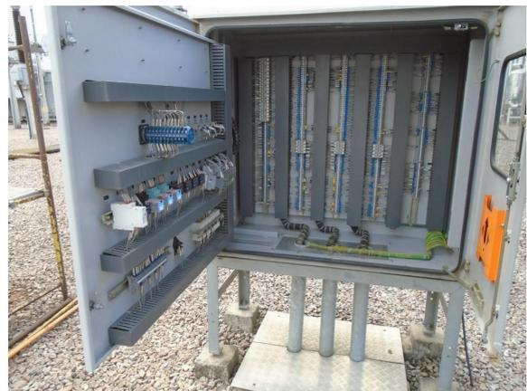
Figura 4.3-Painel de comando disjuntor 52.92, barra de transferência.
