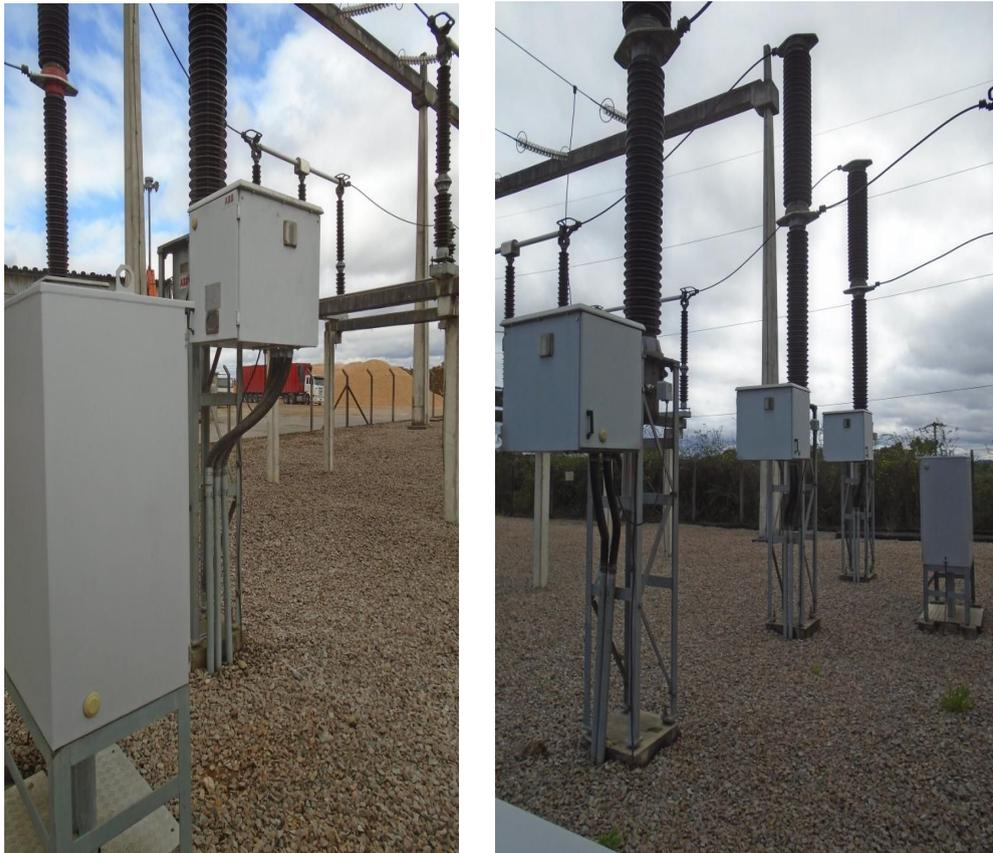
Figura 4.2- Disjuntor barra de transferência
