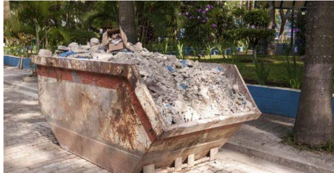
Figura 8 - Gestão correta de resíduos sólidos Fonte: condomiosc.com.br
