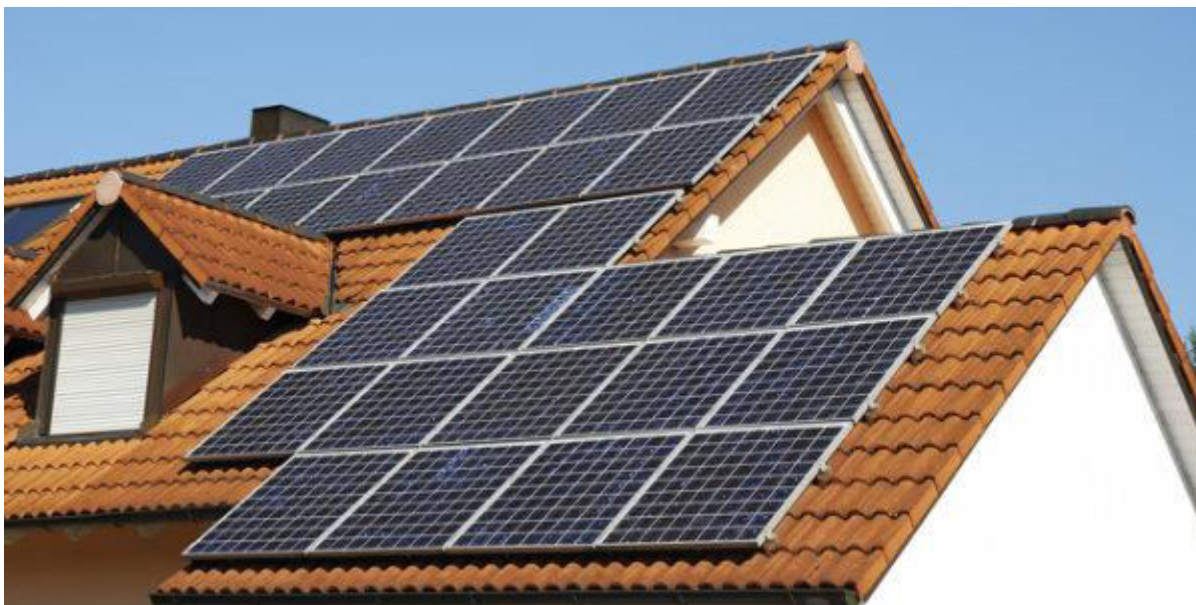
Figura 7 - Exemplo de um sistema fotovoltaico distribuído conectado à rede elétrica Fonte: Solar Brasil, 2017.
