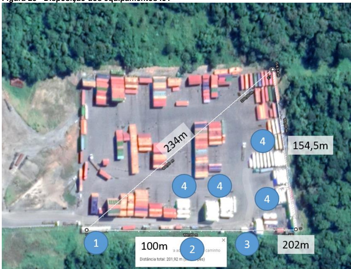
Figura 23 - Disposição dos equipamentos IoT
