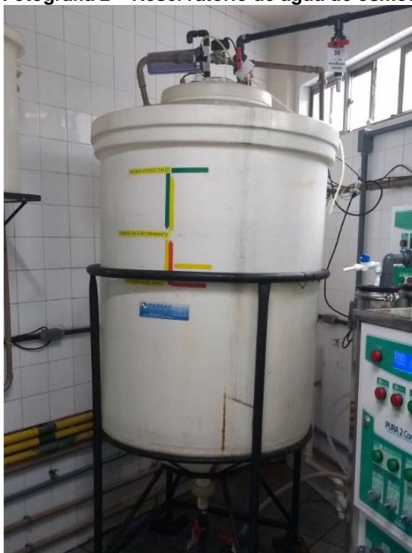
Fotografia 2 – Reservatório de água de osmose fonte do estudo
