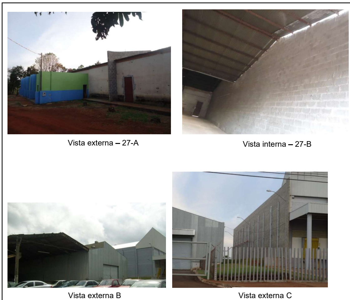
Figura 27 – Isolamentos através de Parede Corta Fogo. Fonte: Aatoria própria.
