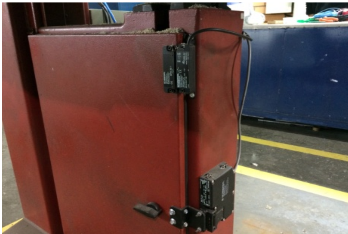
Figura 12 – Imagem Local – Portas de acesso Serra Fita (DEPOIS DA ADEQUAÇÃO) Fonte: EOLD
