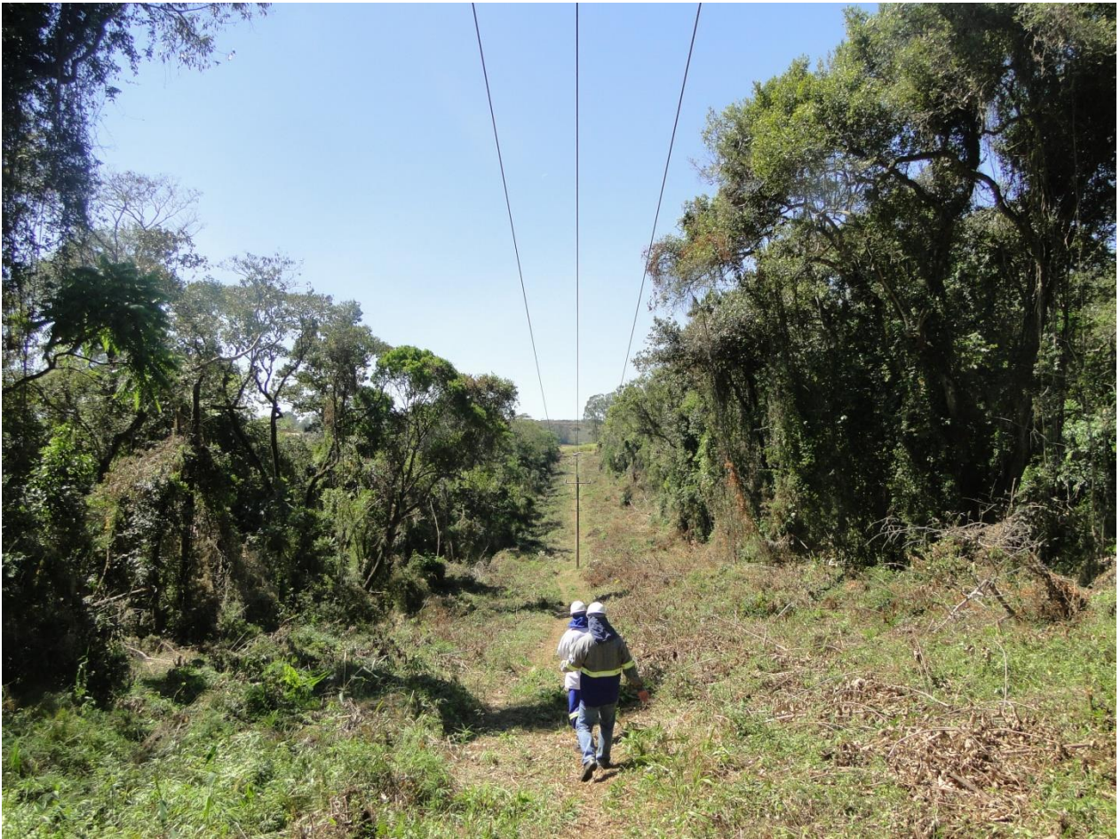
Figura 8 - Inspeção a pé sob a rede elétrica Fonte: Autoria própria.
