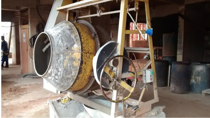
Foto 5 – Proteção da correia da betoneira na obra 1 Fonte: Autoria própria
