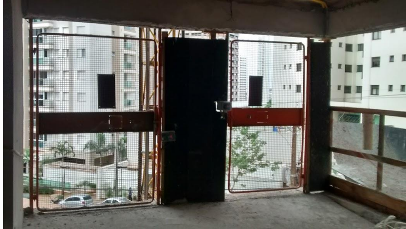
Foto 7 – Proteção de áreas abertas na obra 3 Fonte: Autoria própria
