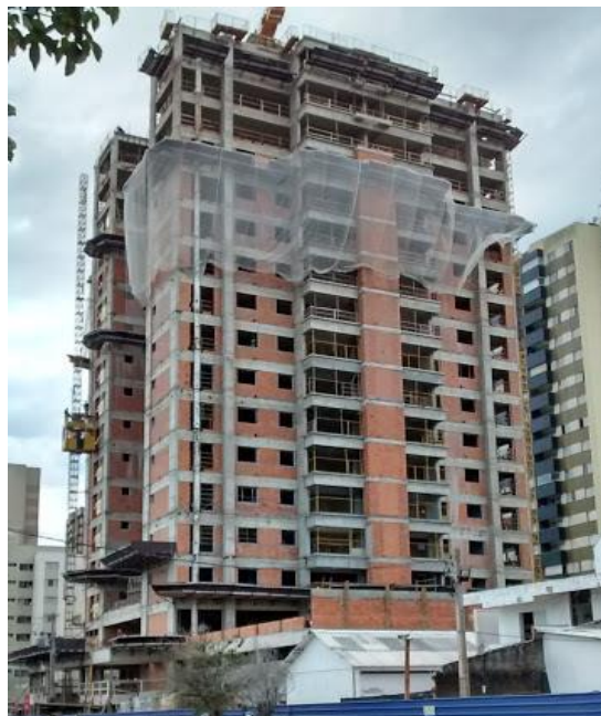
Foto 2 – Obra 2 Fonte: Autoria própria
