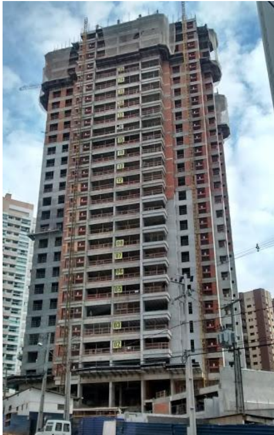
Foto 3 – Obra 3 Fonte: Autoria própria
