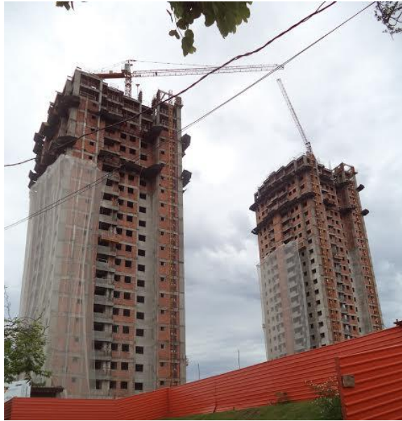
Foto 1 – Obra 1 Fonte: Autoria própria
