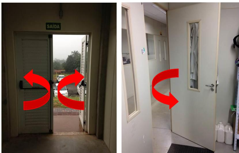
**Figura 9 - Sentido de Abertura das Portas: Portas entradas/saídas do bloco; Portas entradas/saídas dos laboratórios de pesquisa.**
