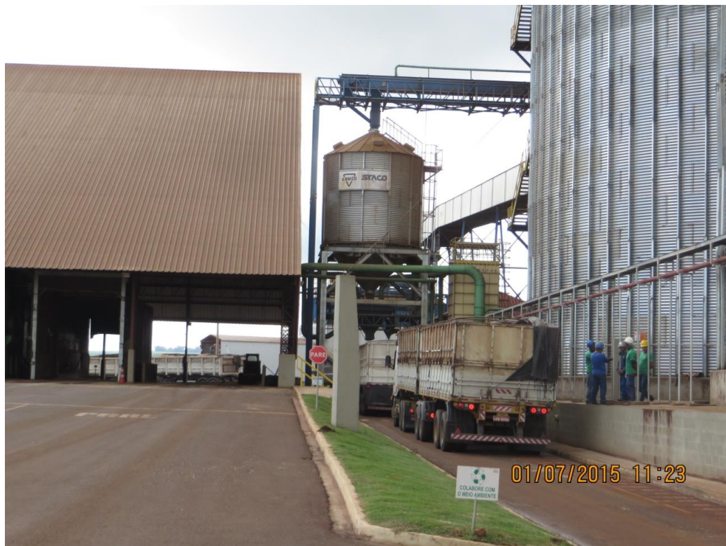
Figura 8 - Silo para expedição rodoviária de grãos Fonte: Arquivo pessoal da empresa estudada
