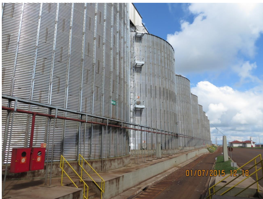
Figura 6 - Silos armazenadores de grãos Fonte: Arquivo pessoal empresa estudada
