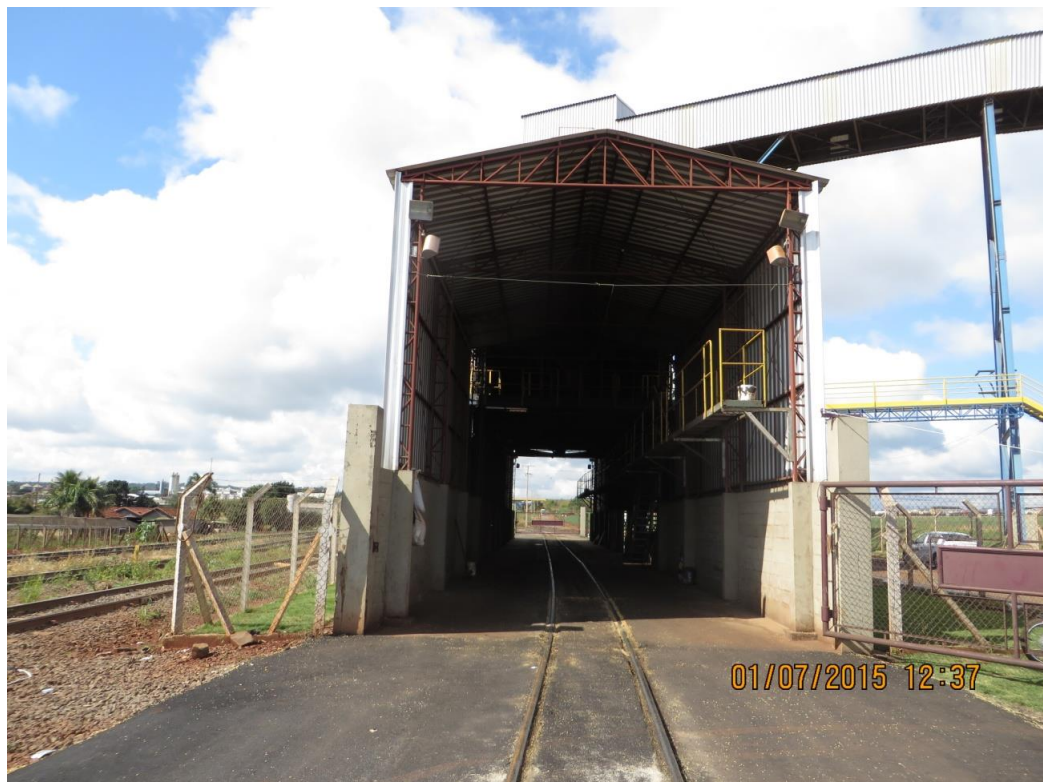
Figura 7 - Tulha para expedição ferroviária de grãos Fonte: Arquivo pessoal empresa estudada
