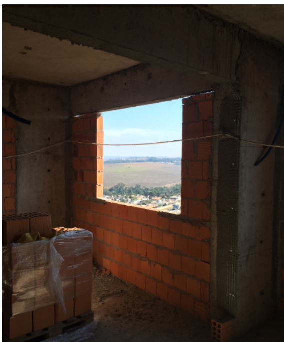
Fotografia 8 – Pontos de ancoragem em estrutura de concreto na obra “B”. Utilização de parafuso olhal.
