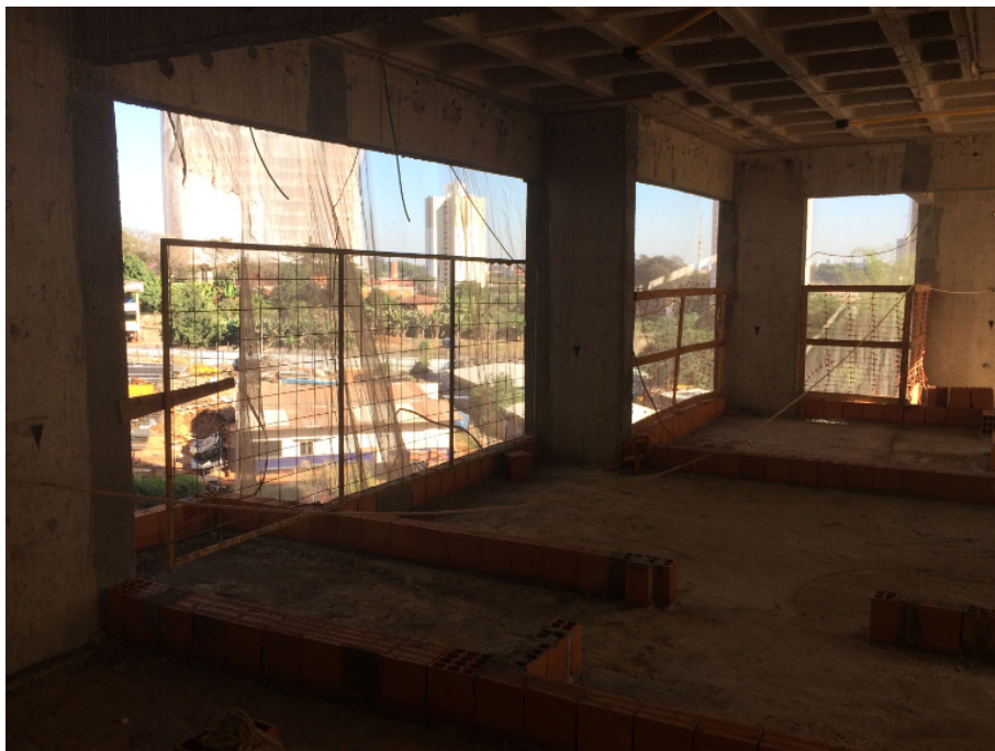
Fotografia 11 – Linhas de vida na obra “A” com altura menor que 1,50m.
