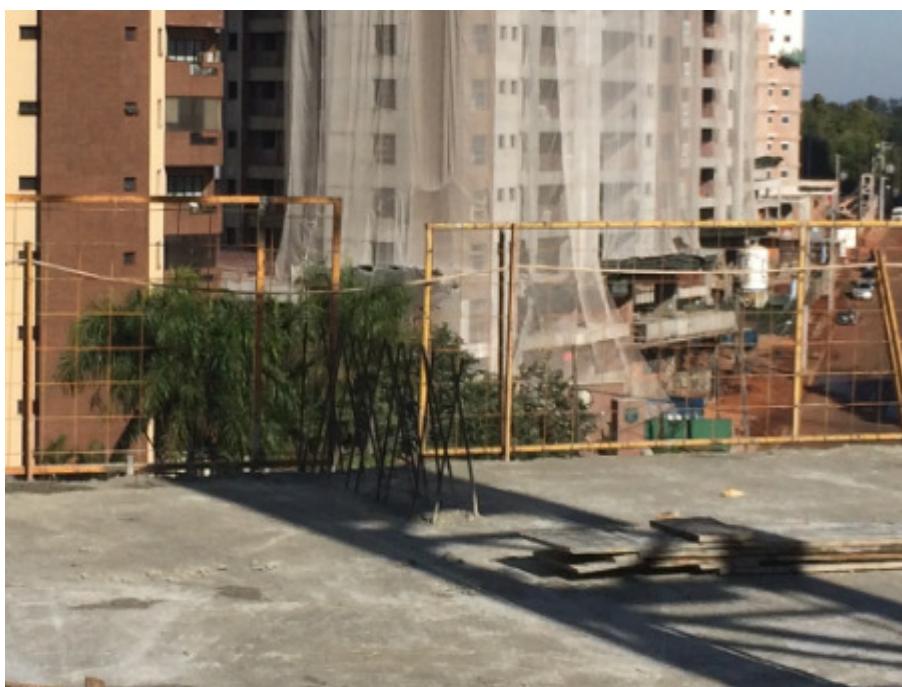
Fotografia 17 – Linhas de vida na obra “A” com altura menor que 1,50m.
