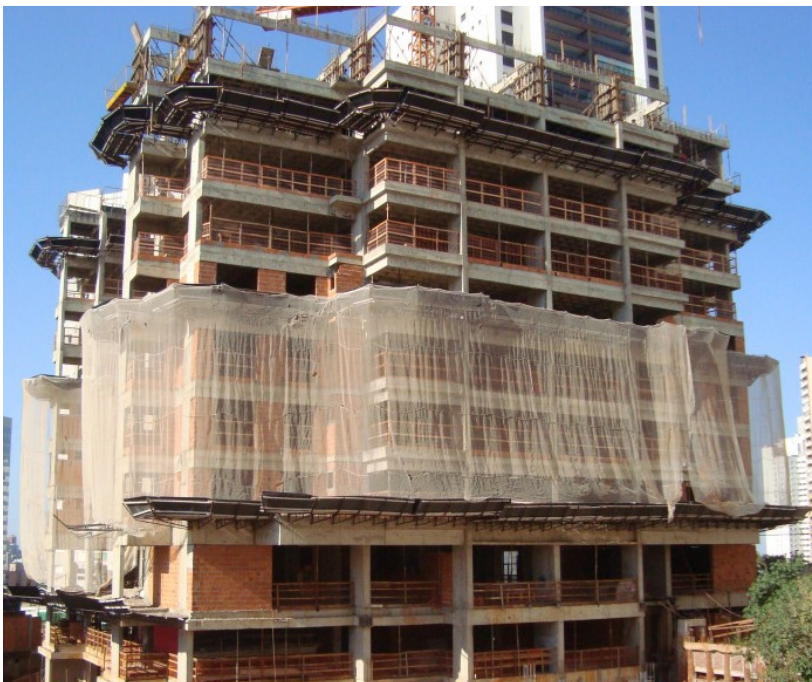
Fotografia 1 – Vista geral da fachada da obra “A” em julho de 2016
