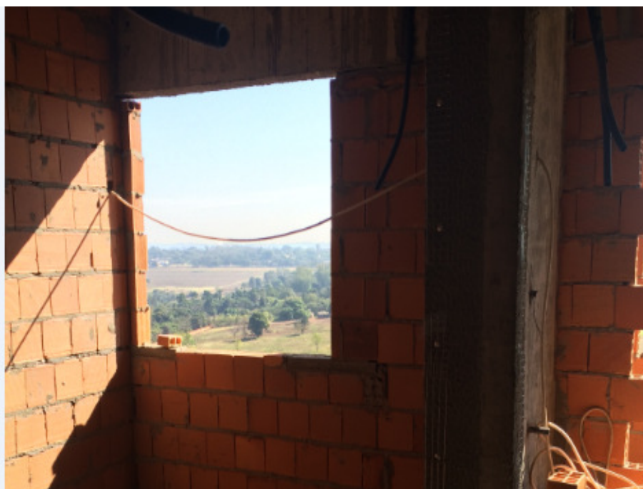
Fotografia 14 – Linhas de vida não externas às estruturas de trabalho na obra “B”.
