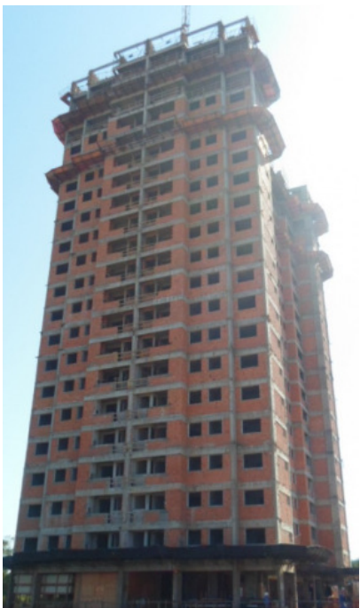
Fotografia 2 – Vista geral da fachada da obra “B” em julho de 2016
