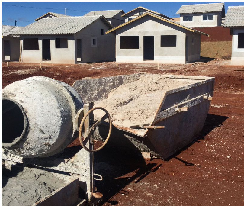
Fotografia 1 – Depósito de argamassa de cal hidratada em canteiro de obra
