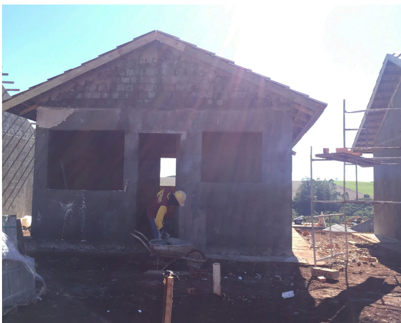
Fotografia 3 - Colaboradores executando o serviço de revestimento reboco
