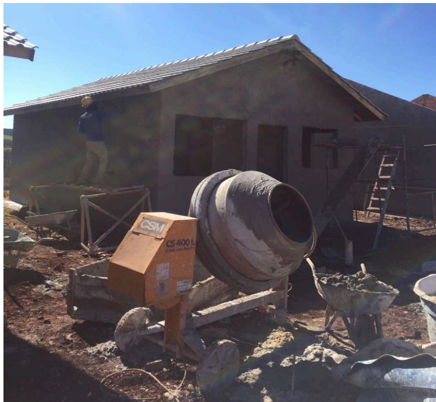
Fotografia 4 - Colaboradores executando o serviço e produzindo a mistura dos materiais in loco
