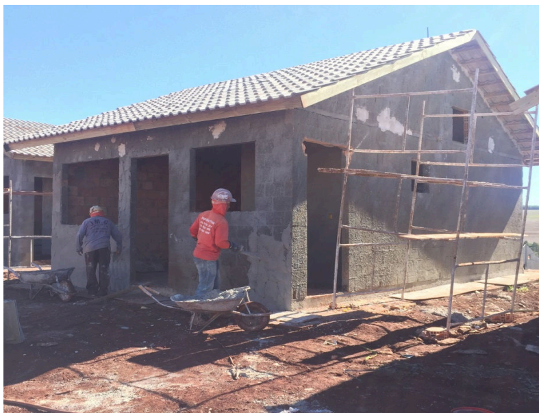
Fotografia 2 - Colaboradores executando o serviço de revestimento reboco
