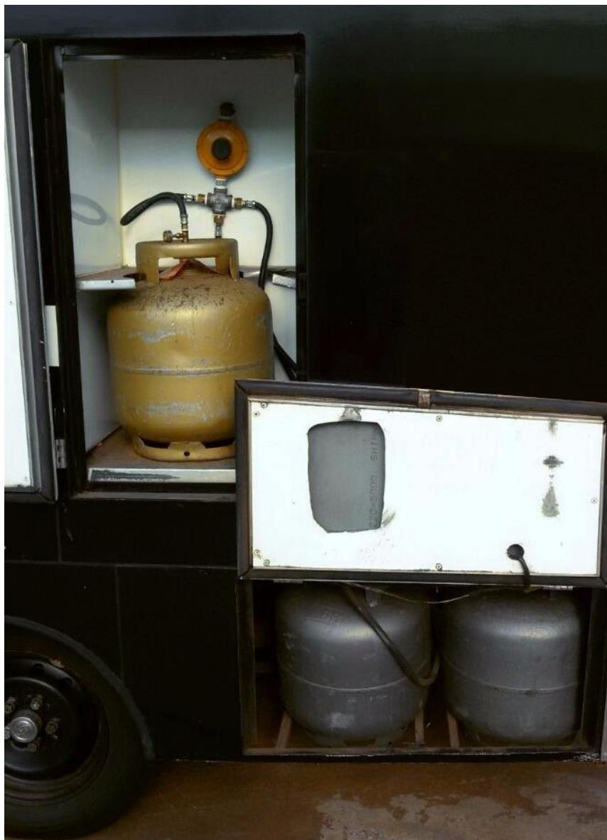
**Figura 3: Armazenagem dos botijões P-13**
