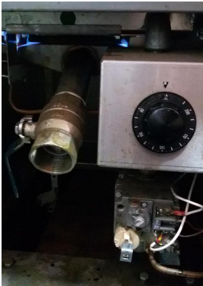
**Figura 4: Regulagem da temperatura por meio do termostato manual**
