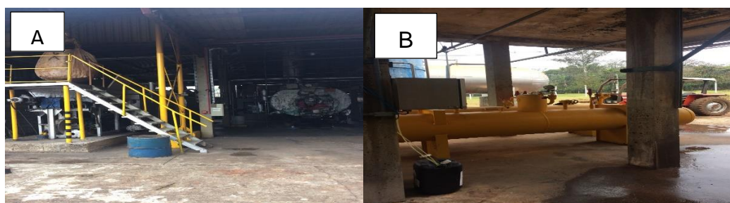
Fotografia 15- Ambiente de Trabalho do Setor de Utilidades Fonte: Autoria própria
