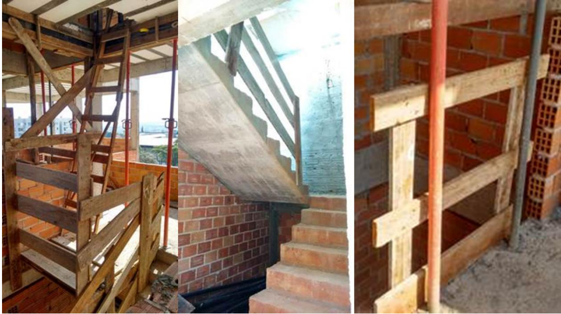
Figura 4: Detalhes das escadas e guarda corpo da obra Fonte: O autor (2018)
