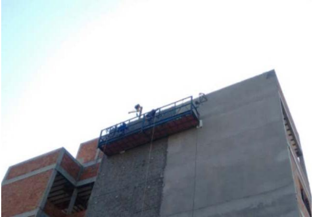
Figura 8: Detalhes do andaime suspenso da obra Fonte: O autor (2018)
