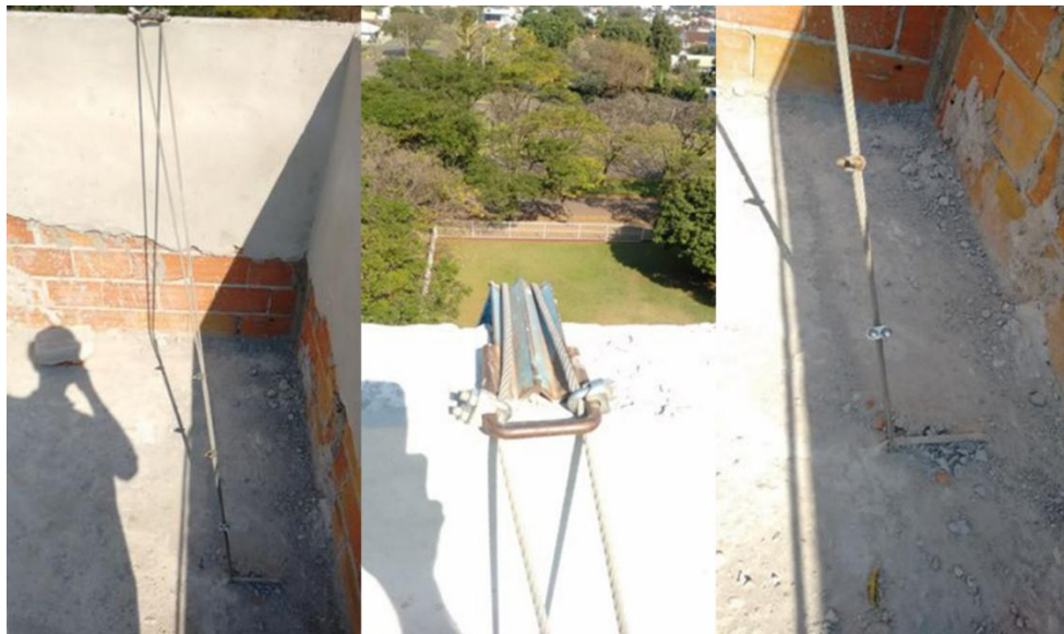
Figura 7: Detalhes da ancoragem do andaime suspenso Fonte: O autor (2018)
