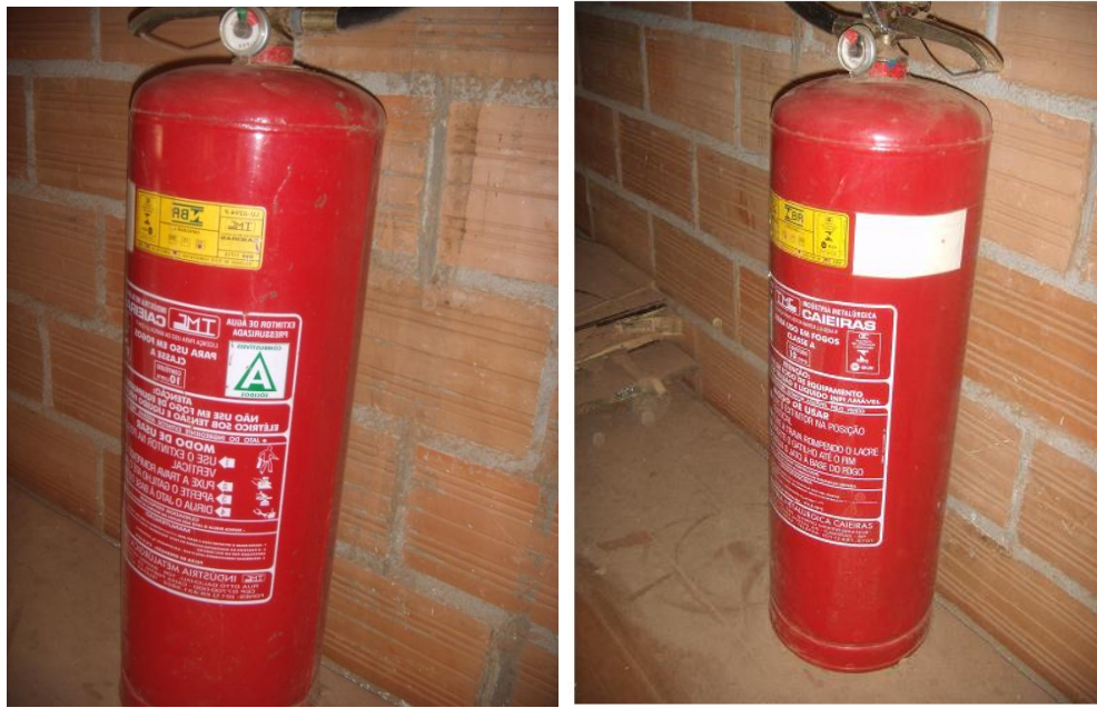
Fotografias 7 e 8 – Foto do único extintor que há na Empresa Madeireira, é de 10kg classe A, visto dos dois lados. Fonte: Höfle, Henrique - 2012.
