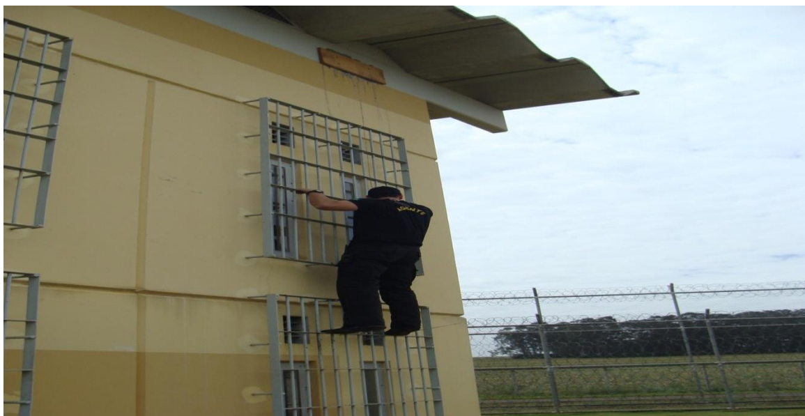
Figura 15: Conferência das entradas de ar para evitar tentativas de fuga.
