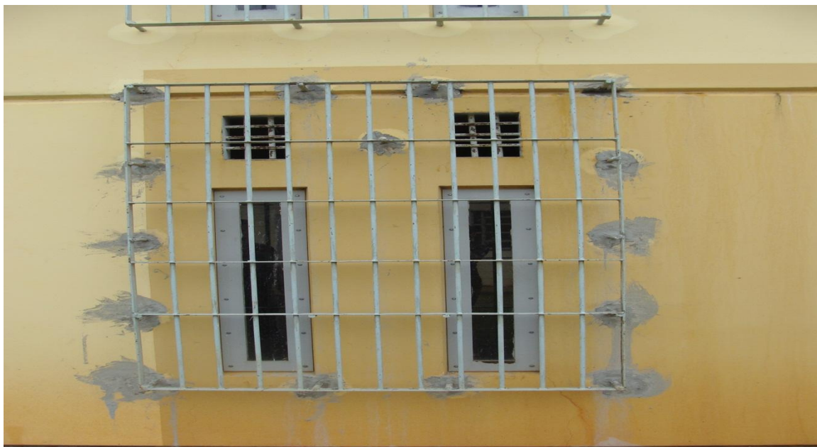
Figura 05: Sistema de ventilação nas celas.
