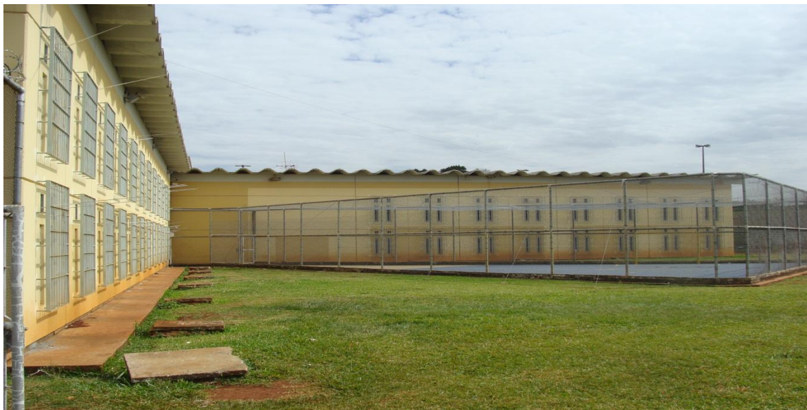
Figura 06: Solário para banhos de sol dos detentos.
