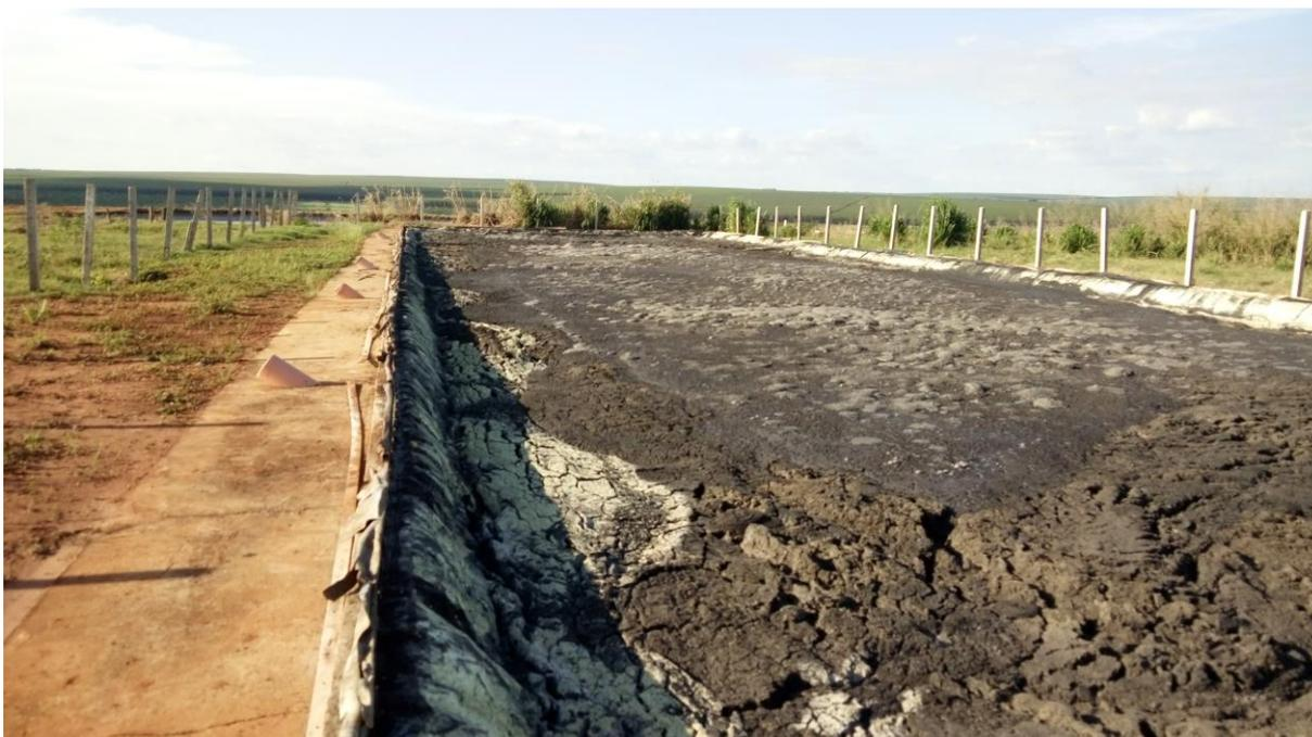
**Figura 9 - Biodigestor Assoreado.**
