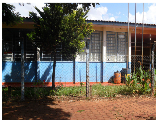
Figura 2: Vista lateral da Escola Heitor de Alencar Furtado
