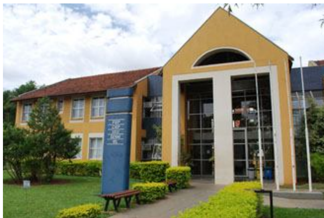
Figura 02 – Fachada Colégio Sesi Cianorte
