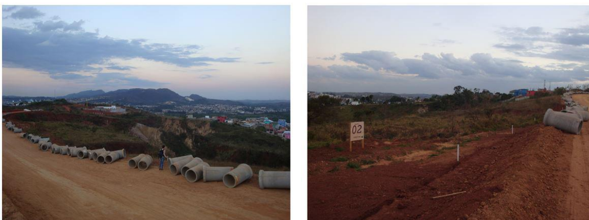
Figura 4- Manilhas do Novo Loteamento, que estão prestes a serem implantadas Fonte: Soares, Resende e Souza (2014, p.32).
