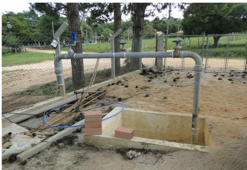
Figura 7 – Instalação do poço já preparada.
