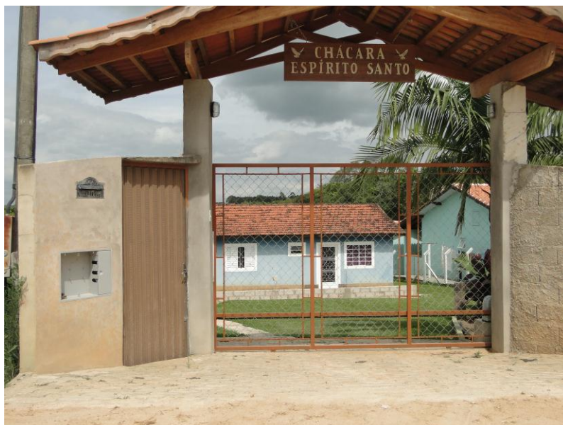
Figura 9 – Ramal domiciliar já preparado.
