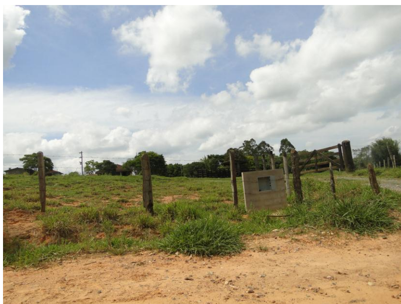
Figura 10 – Ramal domiciliar já preparado.
