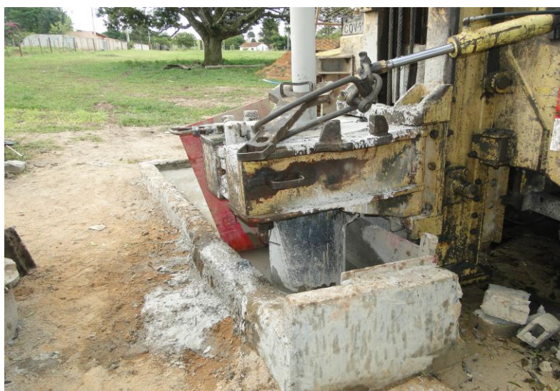
Figura 8 – Perfuração do poço.
