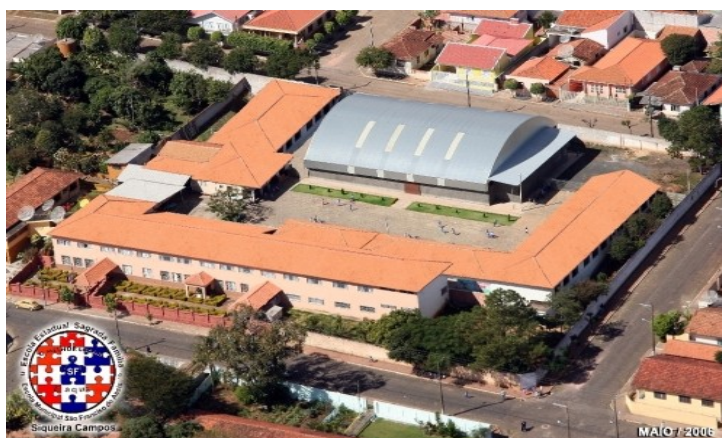
Figura 1 – Foto da Escola Municipal “São Francisco de Assis” Fonte: A Autora (2014)
