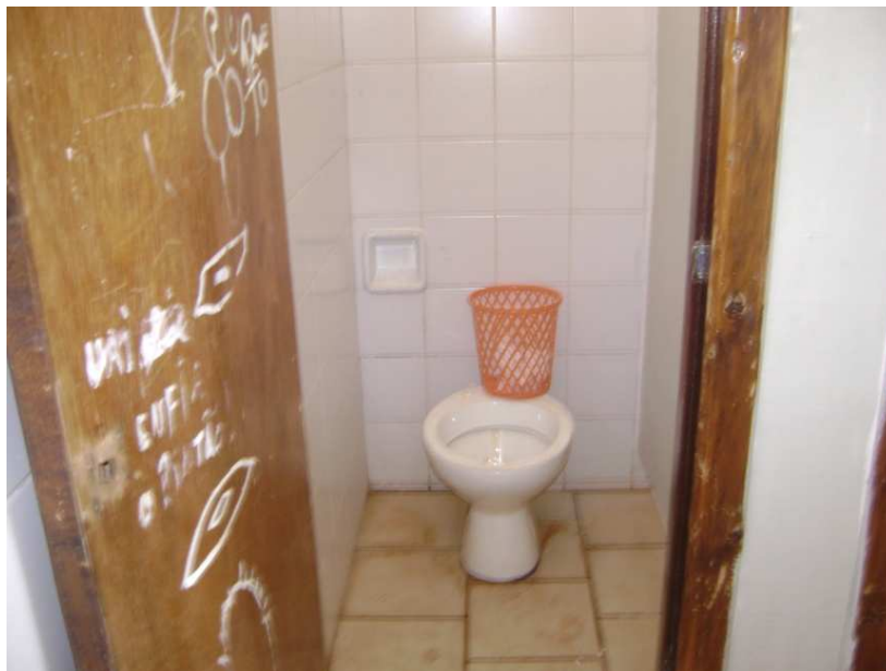
Fotografia 1 – Um dos banheiros da escola
