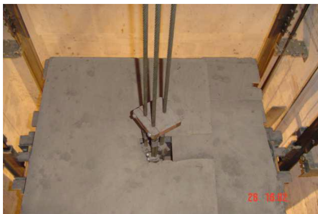
Figura 34: Andaime em cima da cabine.
