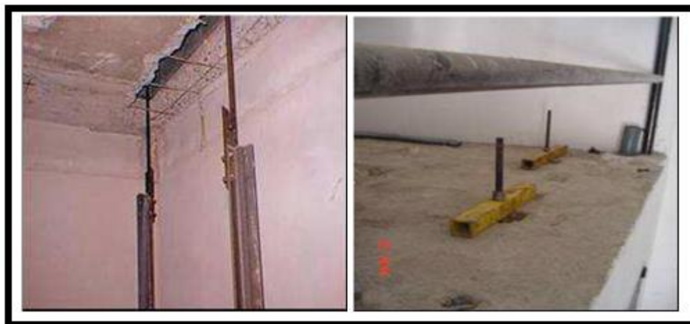
Figura 30: Içamento de guias pelo pendural.
