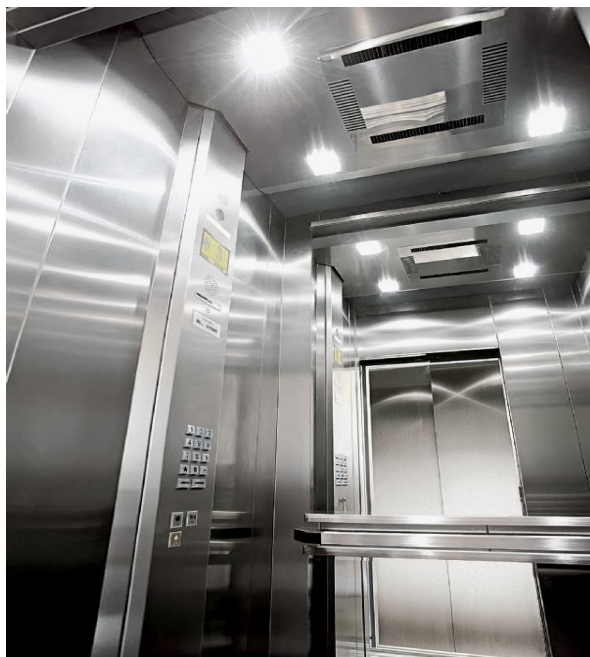
Figura 8: Interior Cabine Elevador
