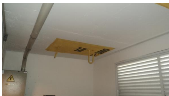
Figura 18: Guacho casa de maquinas.
