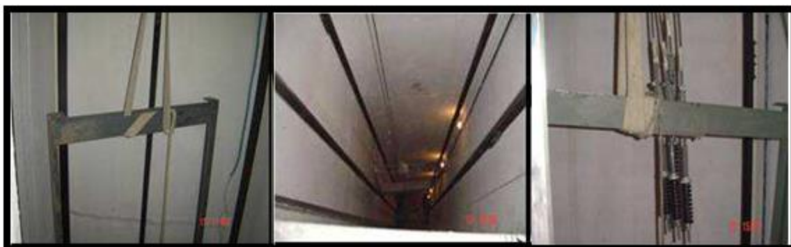
Figura 32: Içamento do contrapeso.
