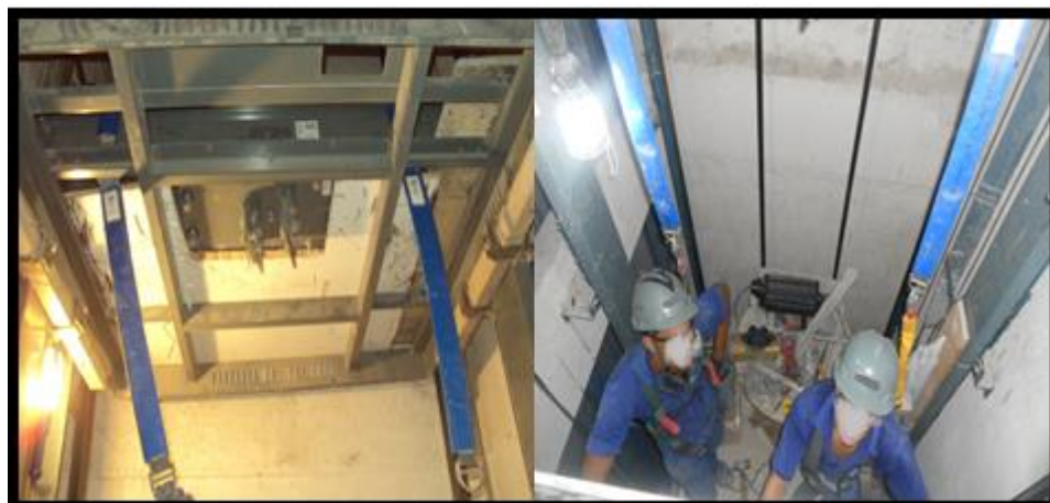
Figura 13: Eslinga, conectadas ao longarina superior da cabine. Fonte: Autor
