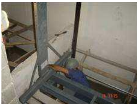
Figura 31: Montagem da cabine em cima da estrutura de madeira.
