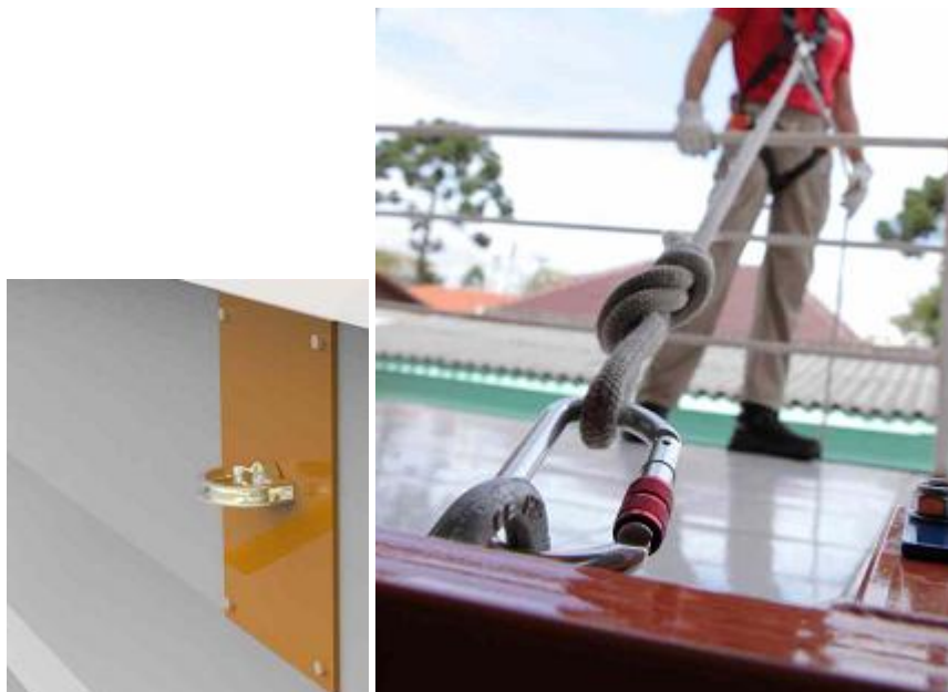
Figura 13 – Gancho fixo na estrutura, para ancoragem de EPI (Altiseg, 2015a)
