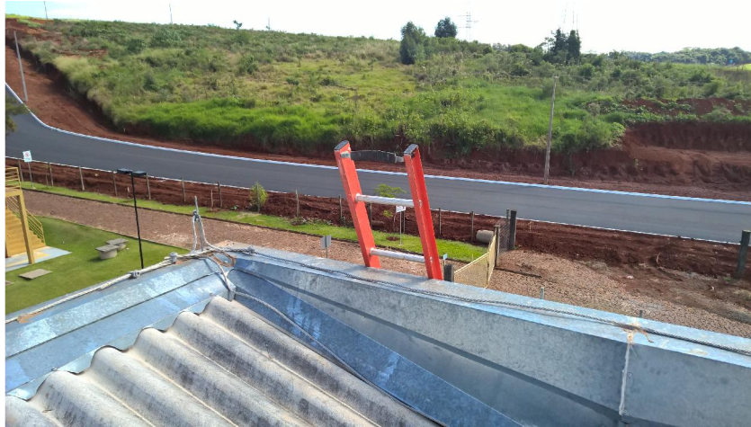
Figura 08 – Topo da escada apoiada na platibanda (Autoria própria, 2015)
