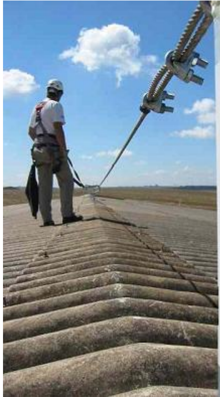
Figura 03 – Trabalhador com cinto de segurança e talabarte ancorado em cabo guia (Altiseg, 2015b)
