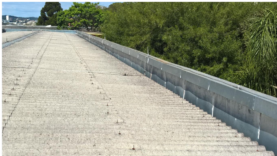
Figura 09 – A cobertura da edificação (Autoria própria, 2015)
