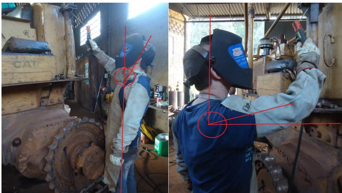
Figura 41 – Posição de soldagem Sobre-cabeça com detalhe de ângulo de pescoço, cotovelo e ombro.
