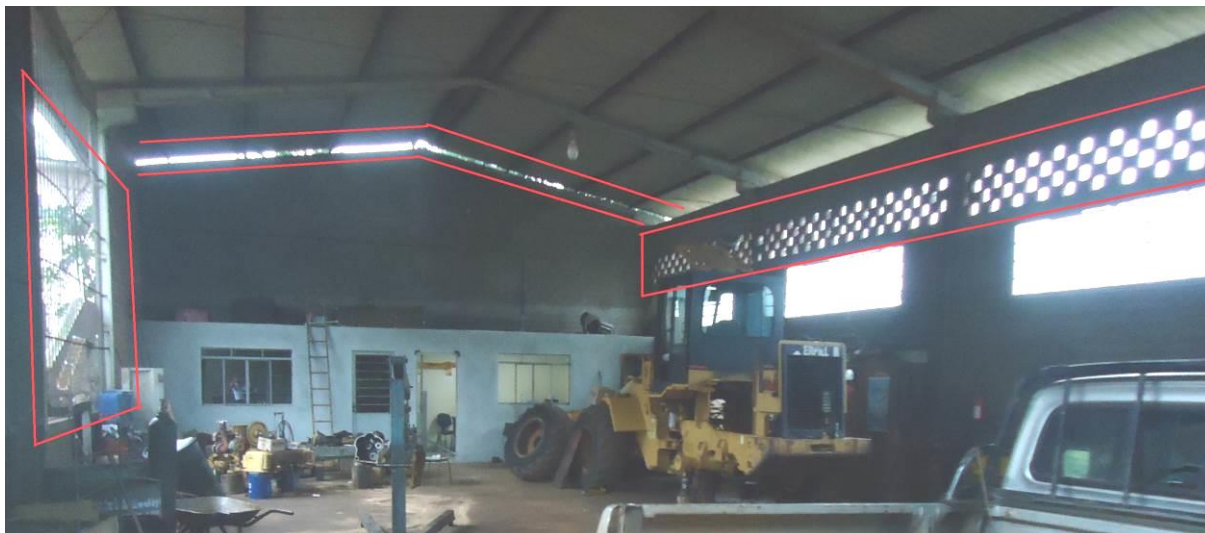
Figura 28 – Aberturas para ventilação natural. Fonte: Acervo do autor.
