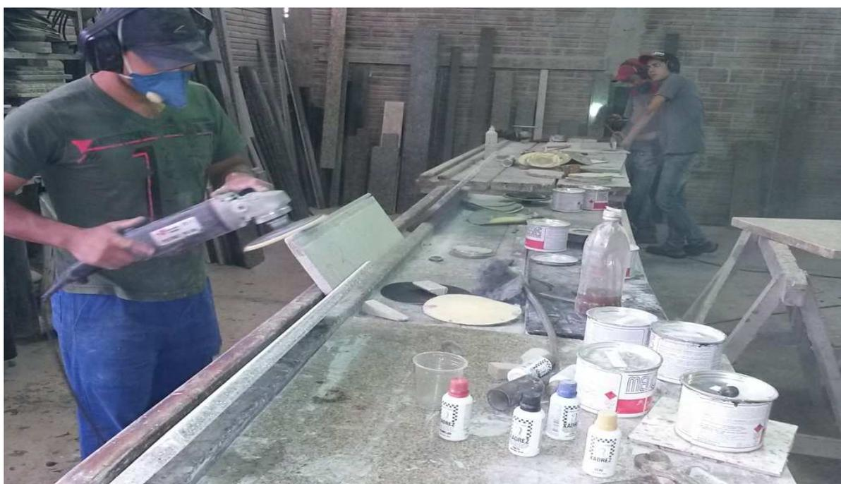
**Figura 11: Serviço de desbaste e lixamento das bordas**
