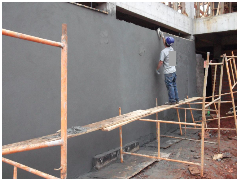
Figura 18 – Andaime com estrutura metálica
