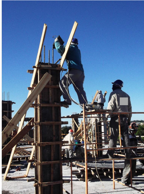
Figura 12- Concretagem de Pilares
