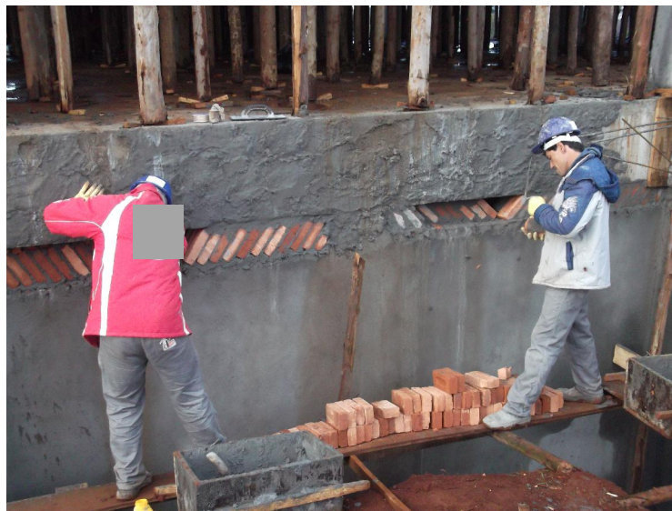
Figura 15 - Deposição de materiais sobre o andaime
