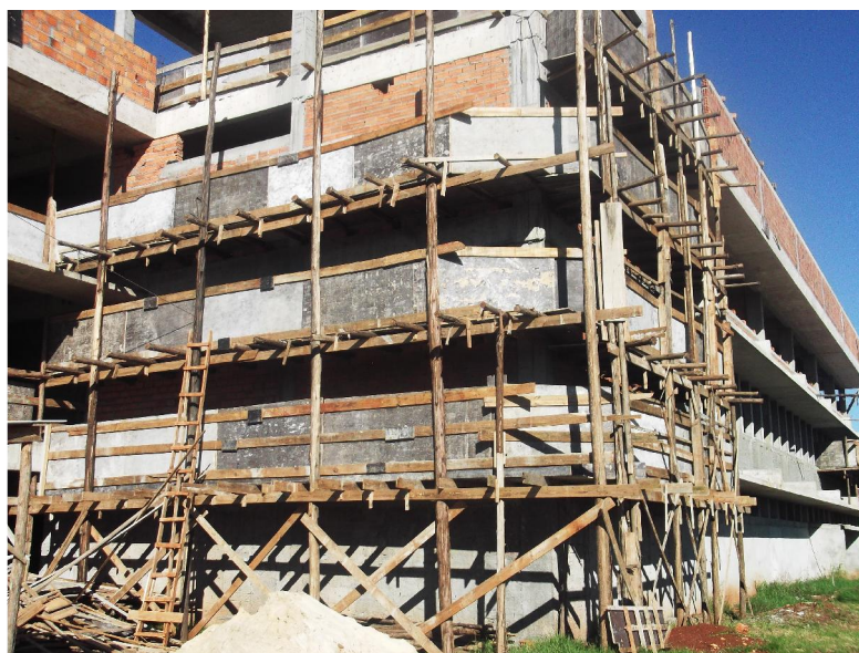
Figura 20 – Andaime fachadeiro readequado
