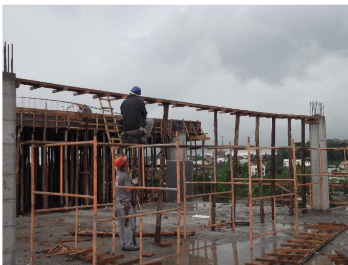
Figura 5 - Posicionamento do painel de fundo da viga
