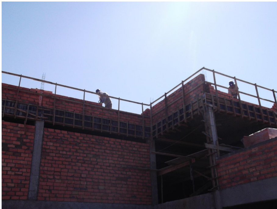
Figura 16 – Proteção de periferia durante o levantamento de alvenaria
