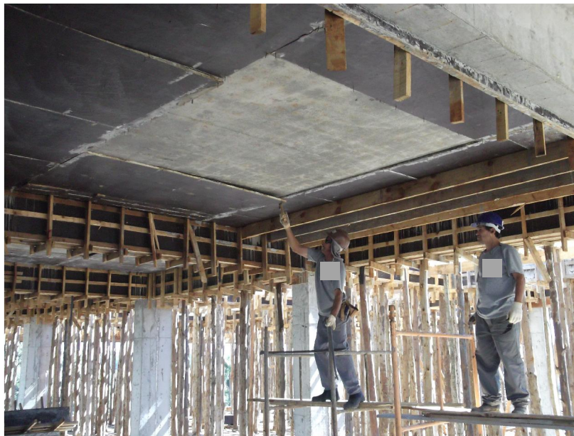
Figura 13 - Desforma de Laje
