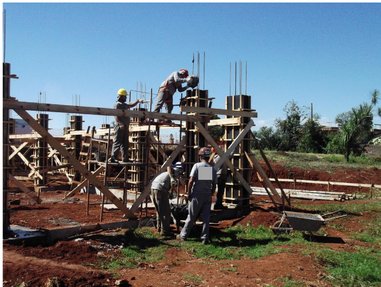
Figura 11 – Concretagem de pilares
