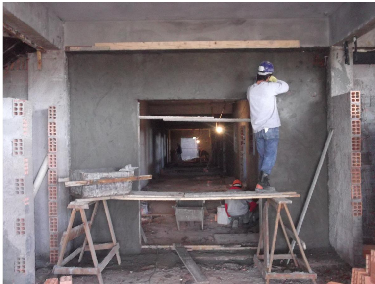
Figura 17 – Andaimos em cavalete para execução de revestimento de parede
