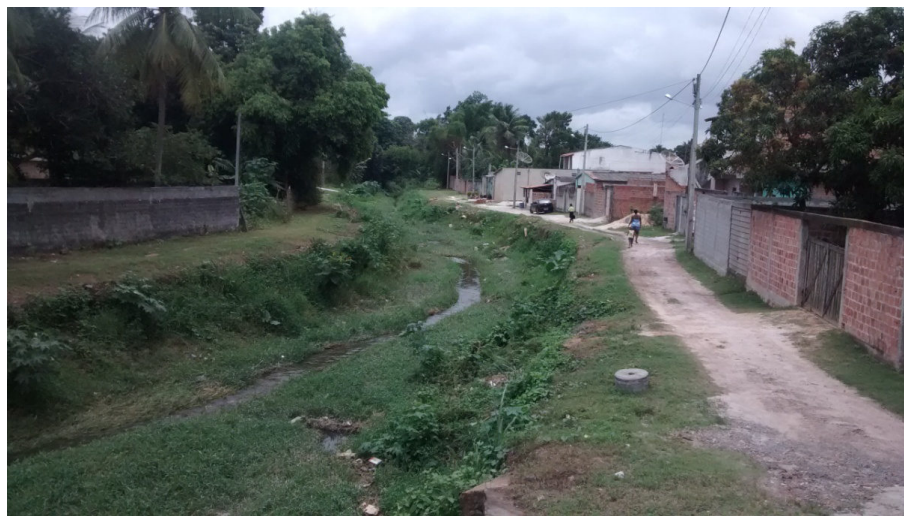
Figura 04: Fotografia de Imóveis Construídos nas Margens da Bacia do Rio Imbassay. Fonte: SEOSP, 2013.
