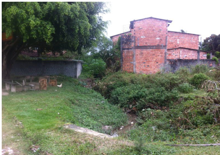
Figura 03: Fotografia de Imóveis Construídos em Área de Preservação Permanente. Fonte: SEOSP, 2013
