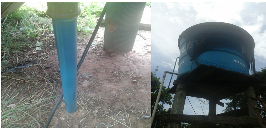
Figura 2: Poço semi artesiano. Fonte: Cedido por uma moradora da zona rural de Tuneiras do Oeste.
