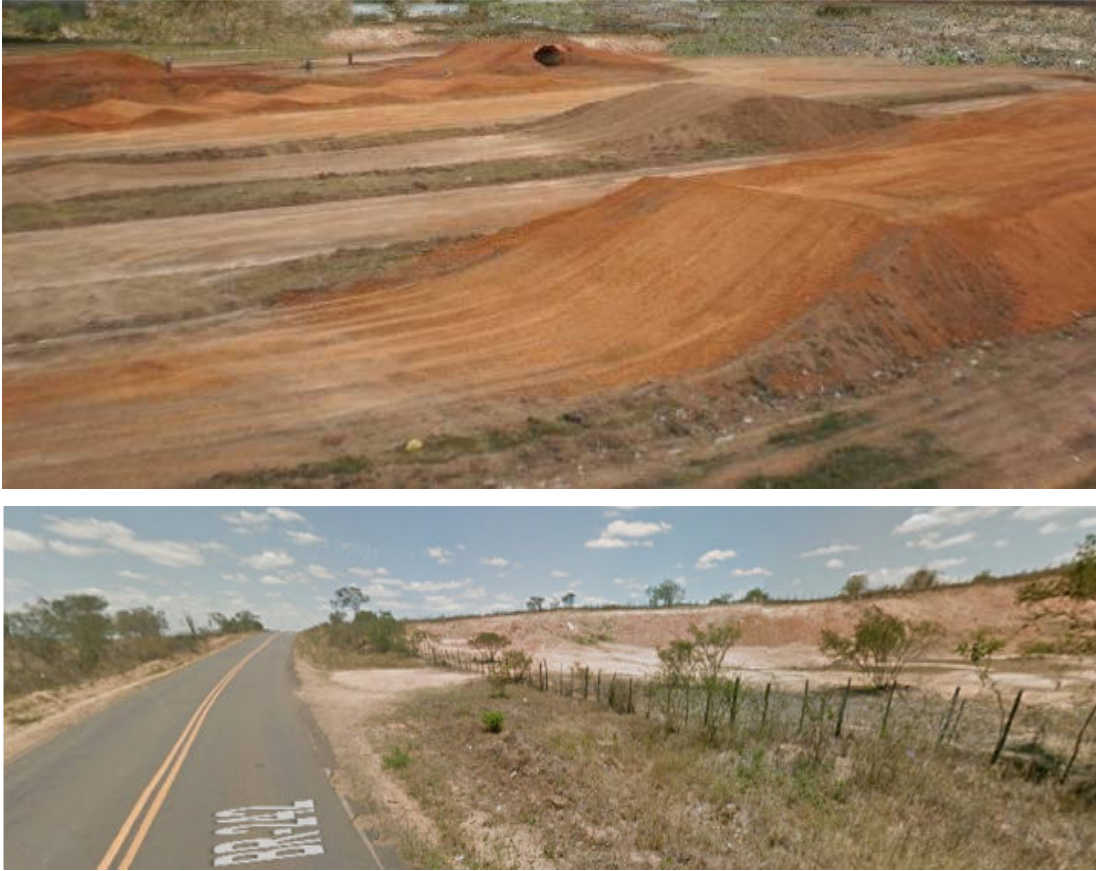
Figura 3. Visão de Como Deverá Ficar a Área Degradada e Acesso a Área da Jazida. Fontes Google Maps, 2015.
