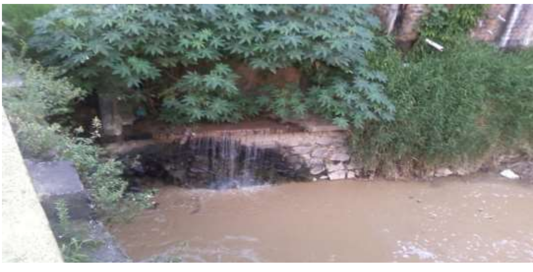
Figura 8 - Lançamento de esgoto doméstico nas margens do Rio Camaçari Fonte:Kátia Costa
