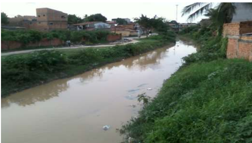
Figura 6 - Casas no entorno do Rio Camaçari Fonte: Rosangela Oliveira (2018)
