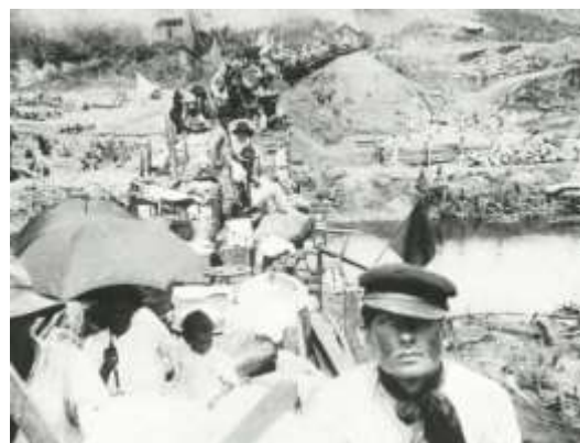
Operários deslocados para o ramal Porto União-São Francisco do Sul.
