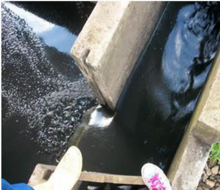
Figura 18: Lodo sendo despejado no Leito de Secagem.
