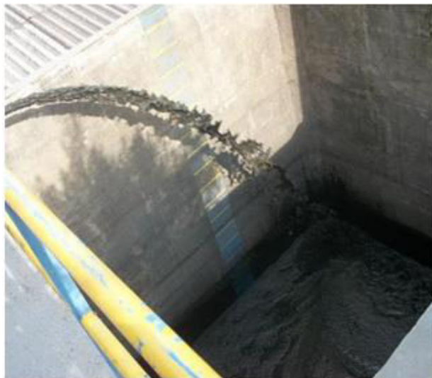
Figura 16: Esgoto sendo despejado na Caixa de Adensamento.
