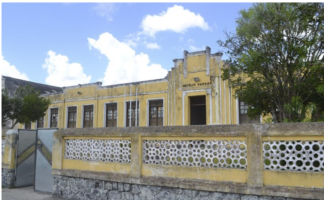
Figura 2, Fachada do Colégio Estadual Getúlio Vargas, Antes da Reforma em 2017. Fonte: Mais Região/Mata de São João, BA, ano, 2017.
