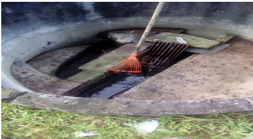
Figura 03 – Sistema de Gradeamento na chegada do Efluente. Fonte: Autora (2018)
