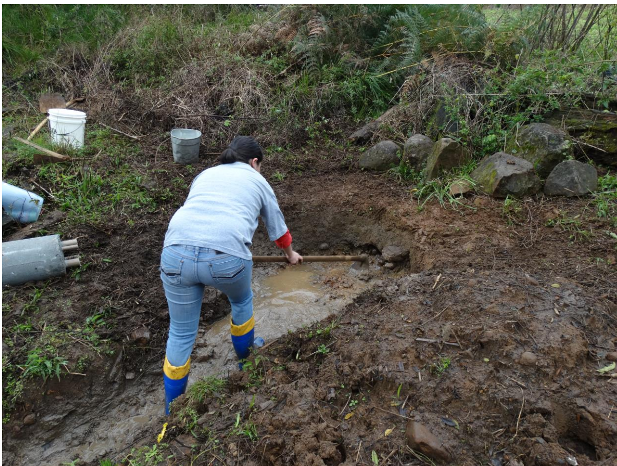
Foto 01: Limpeza manual da área de captação da água Fonte: FUNDEMA, 2014
