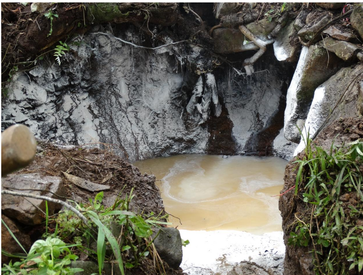
Foto 03: Desinfecção das paredes e fundo da nascente Fonte: FUNDEMA, 2014
