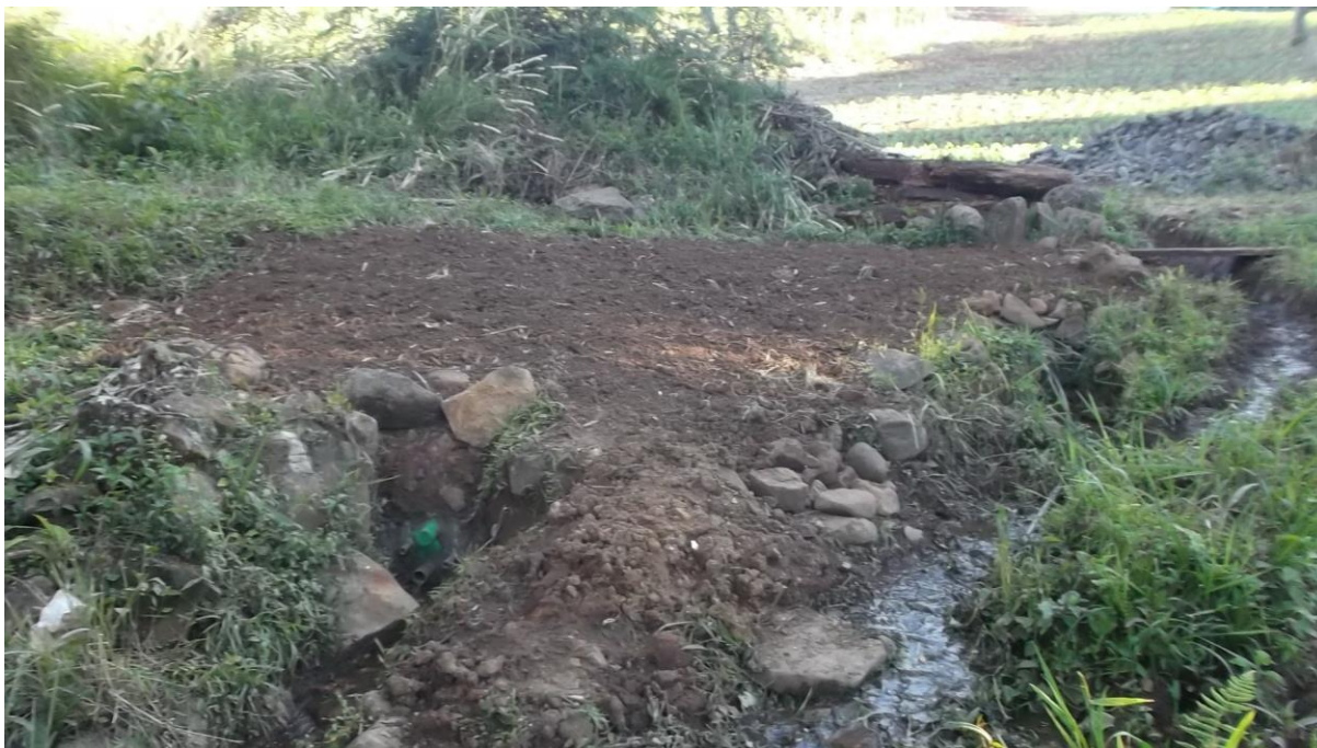
Foto 10: Cobertura de toda a estrutura com terra Fonte: FUNDEMA, 2014
