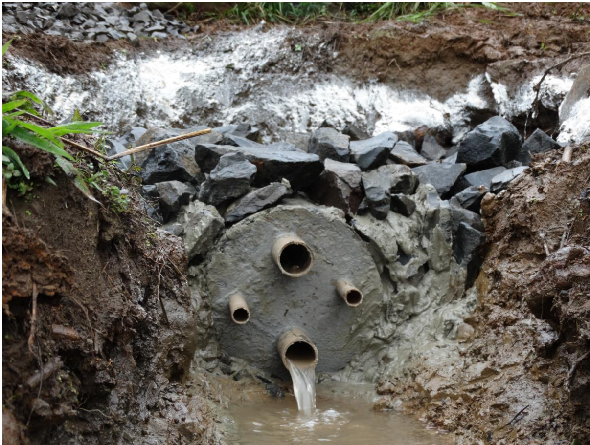
Foto 05: Vedação do tubo na saída da vertente Fonte: FUNDEMA, 2014
