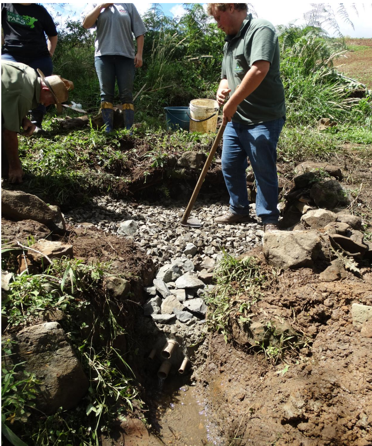
Foto 07: Acomodação das pedras britas sobre as pedras pulmão Fonte: FUNDEMA, 2014
