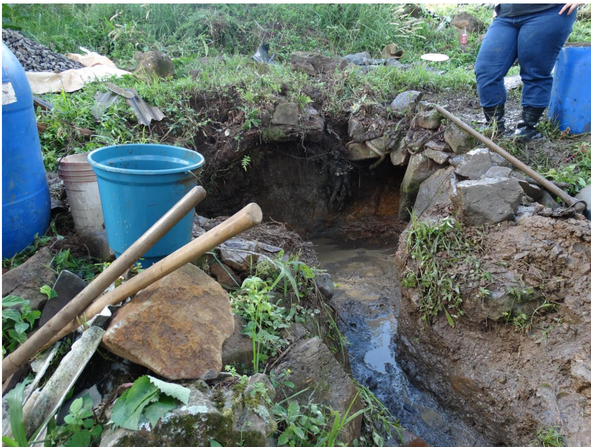
Foto 02: Vala aberta Fonte: FUNDEMA, 2014
