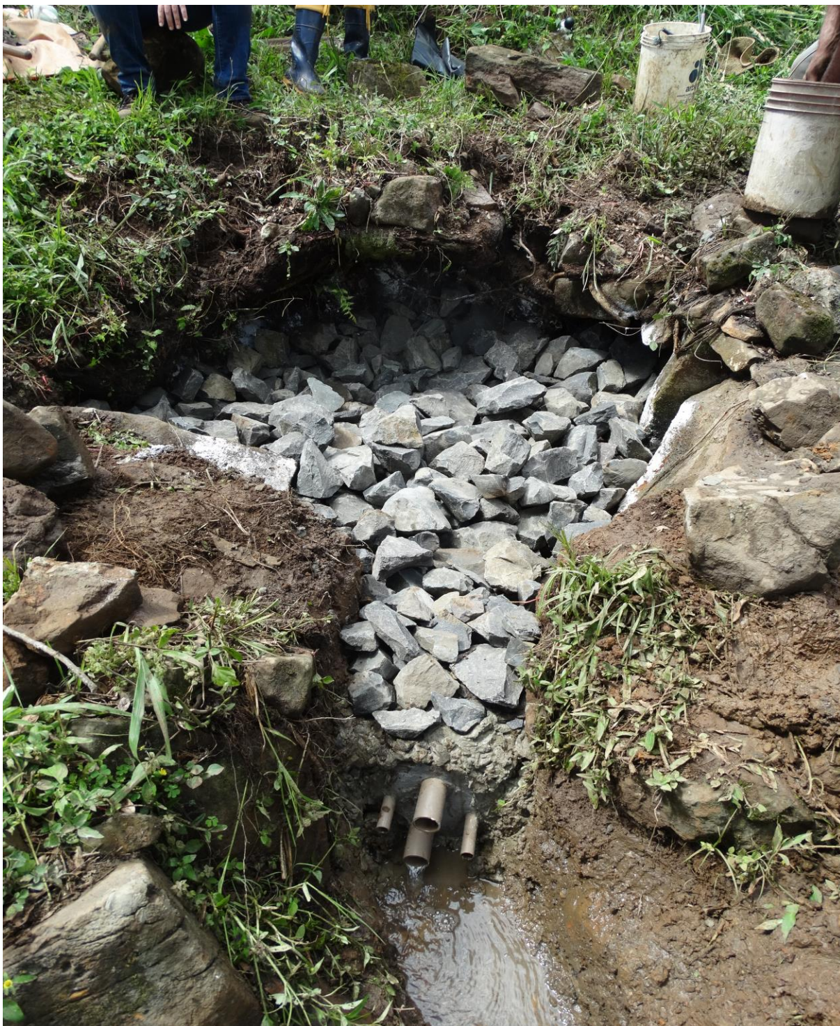
Foto 06: Preenchimento do interior na nascente com pedras pulmão Fonte: FUNDEMA, 2014
