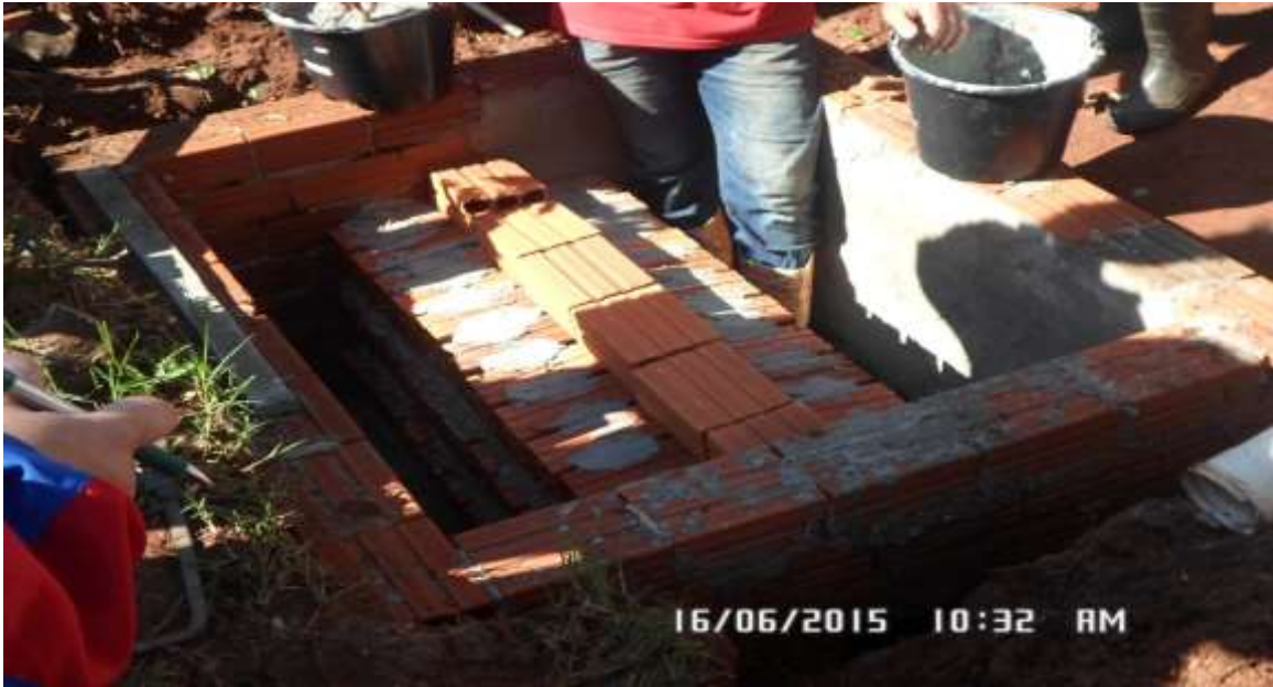
Figura 4: Fossa em Construção. Fonte: Rosemeire M. Tirado/ Tec. em Agropecuária 2015
