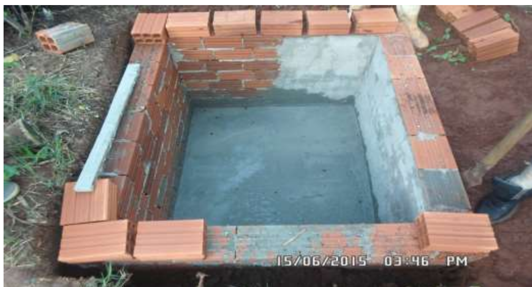
Figura 1: Construção da Estrutura da Fossa.
