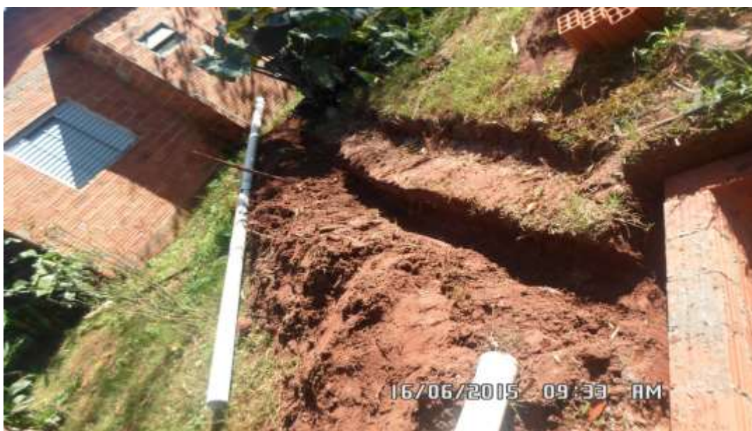
Figura 3: Encanamento do Banheiro para a Fossa.
