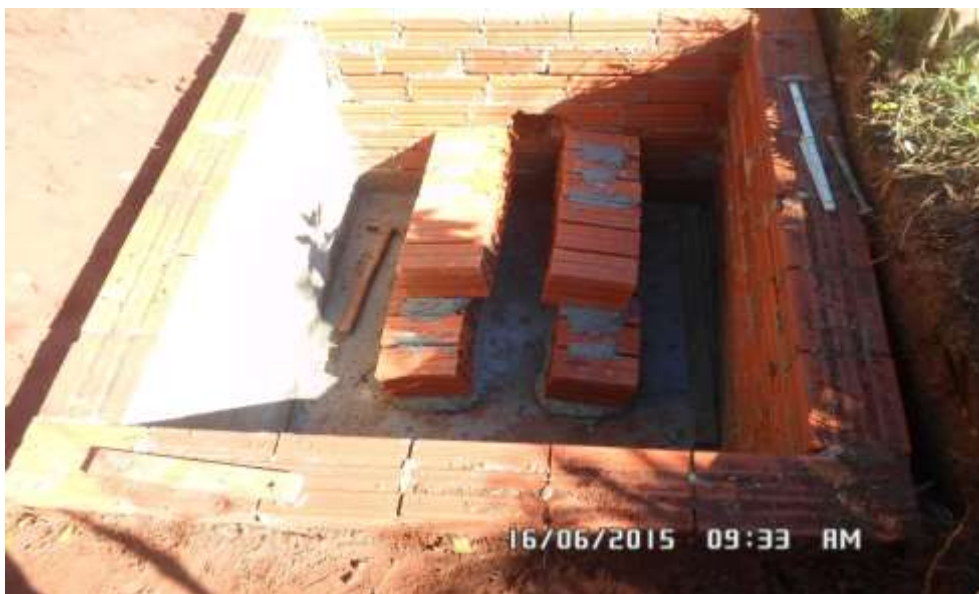
Figura 2: Construção da Parte Interna da Fossa (Pirâmide).
