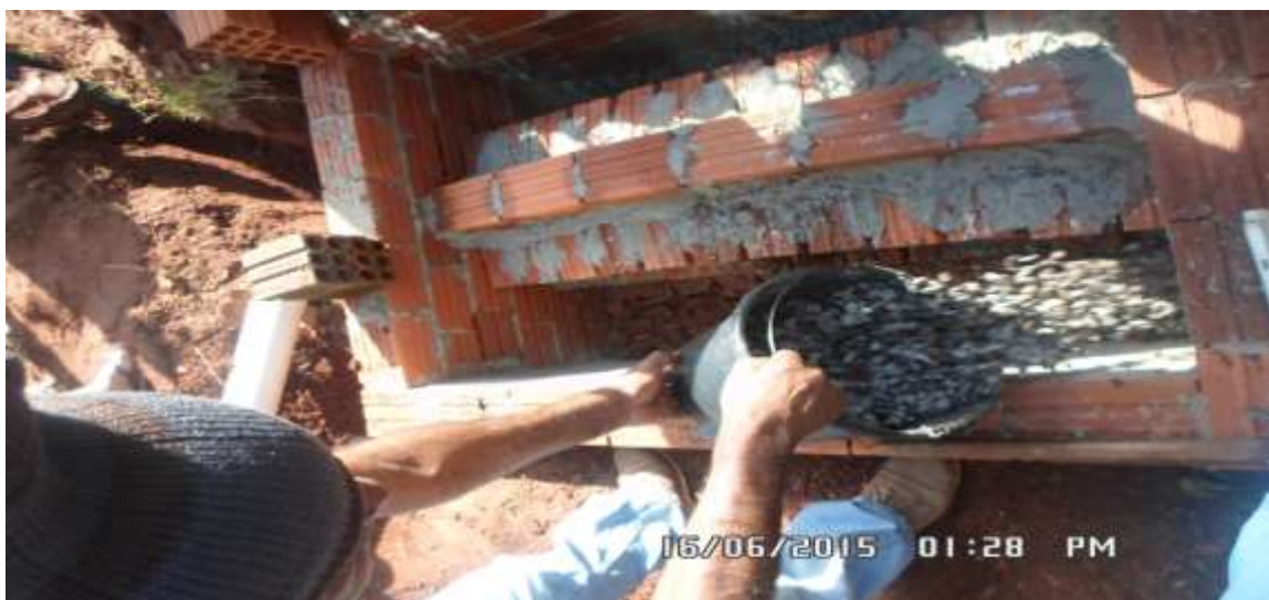
Figura 5: Estrutura da Fossa Pronta. Fonte: Rosemeire M. Tirado/ Tec. em Agropecuária 2015
