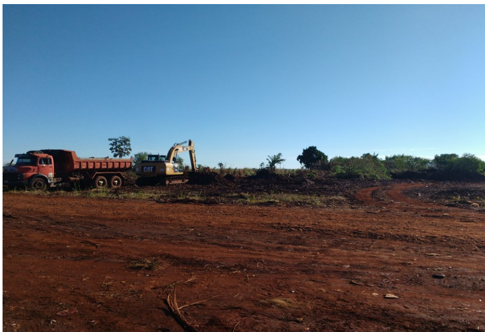
Figura 12 – Preparação e Limpeza da Área
