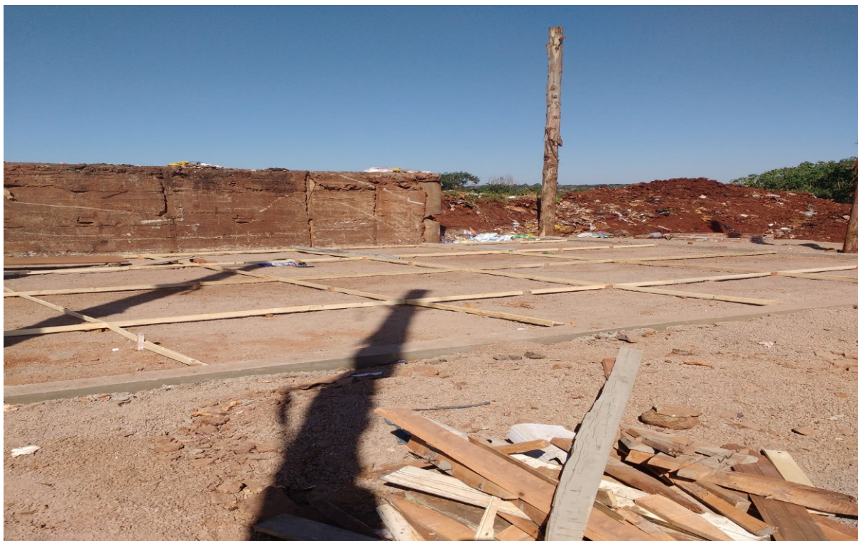
Figura 10 – Construção da plataforma em concreto para acomodação dos contêineres
