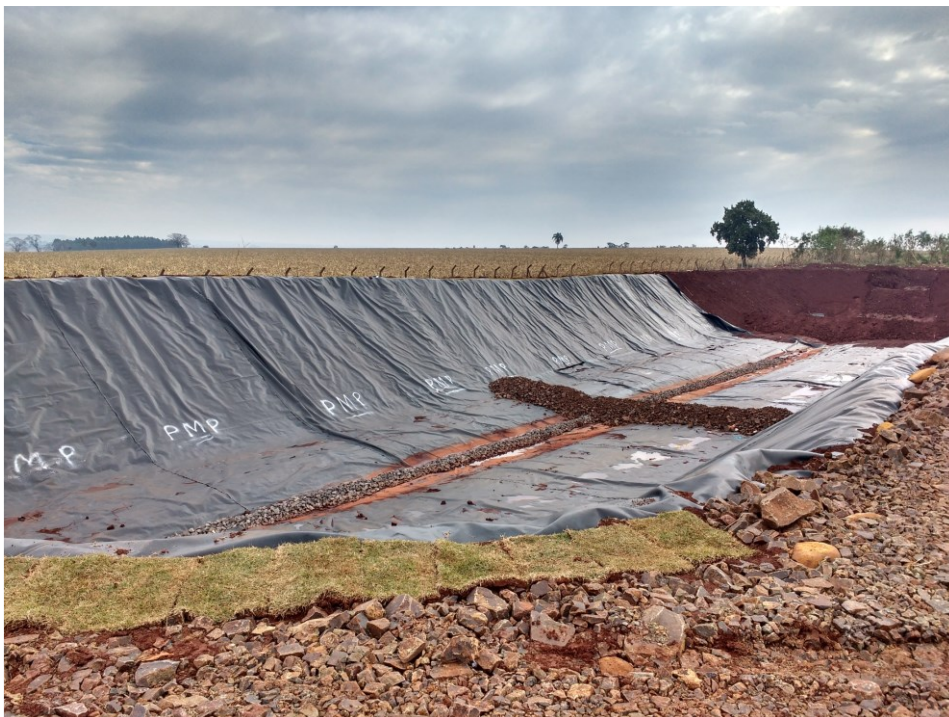
Figura 16 – Vala 1ª etapa concluída
