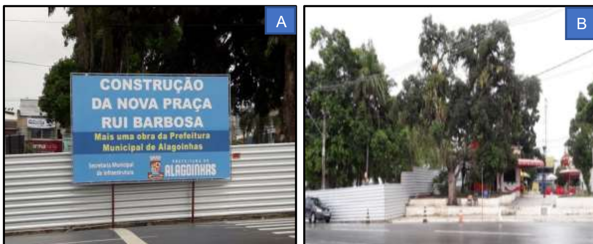
Figura 10 – A: Parte da Praça Rui Barbosa Fechada com Tapume de Metal por Conta das Obras de Revitalização; B: Margens Descobertas da Praça em que não Estão em Obras. Fonte: Autoria própria, 2018.
